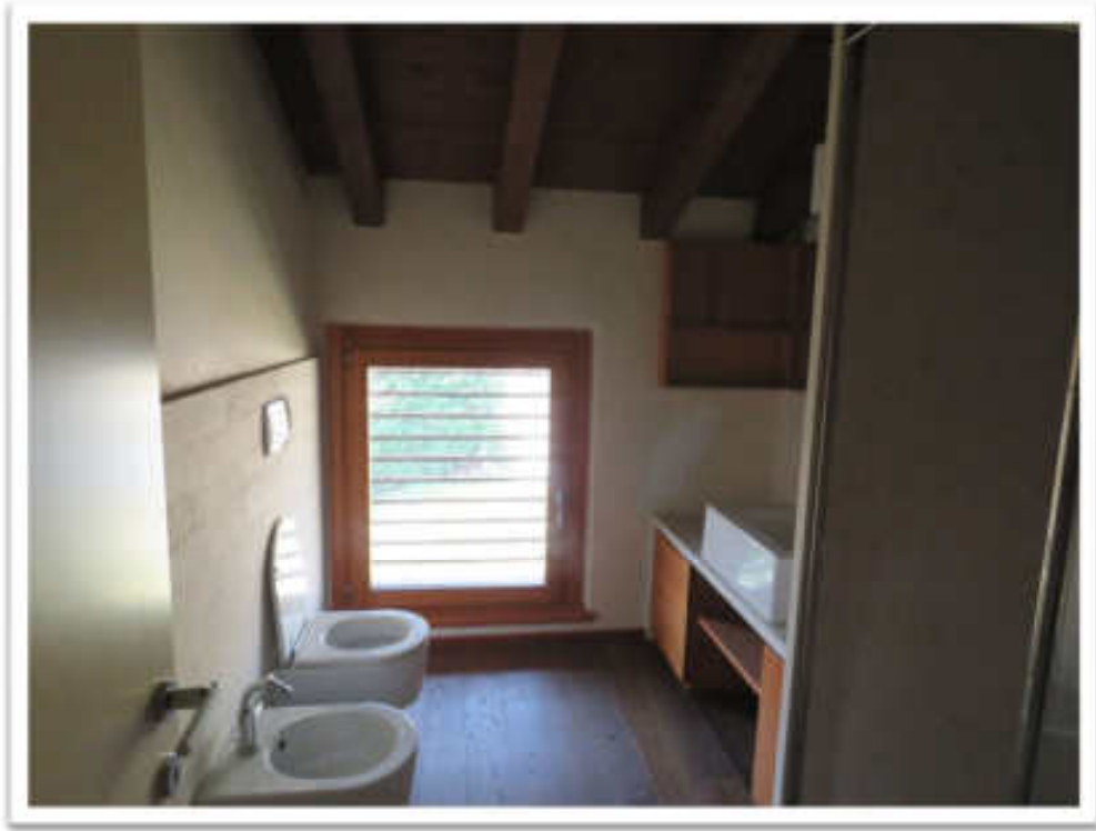
Il primo piano/sottotetto: l'altro bagno.
