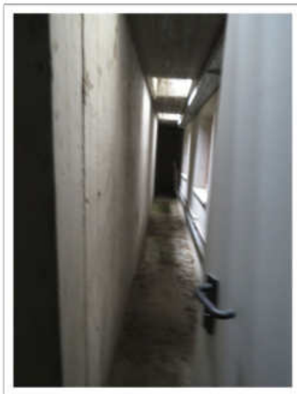
Piano interrato: altro ambiente e particolare dell'intercapedine.
