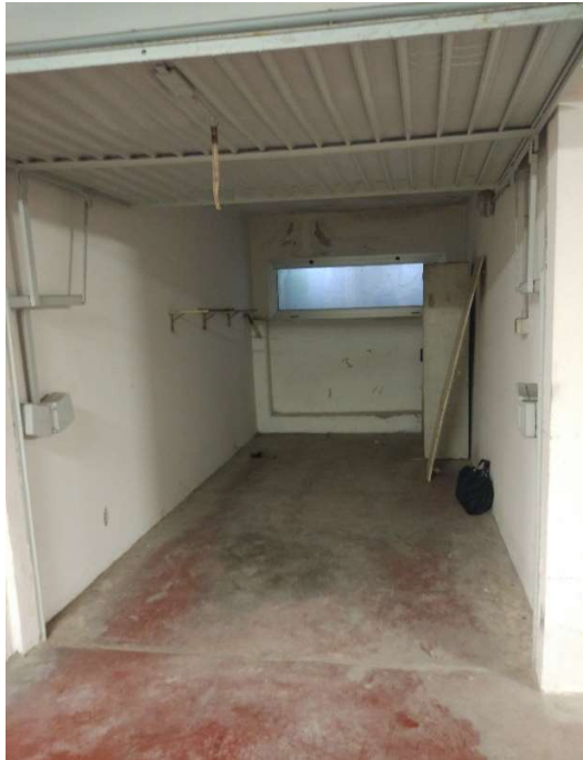
FOTO N. 7 – vista interna del garage
