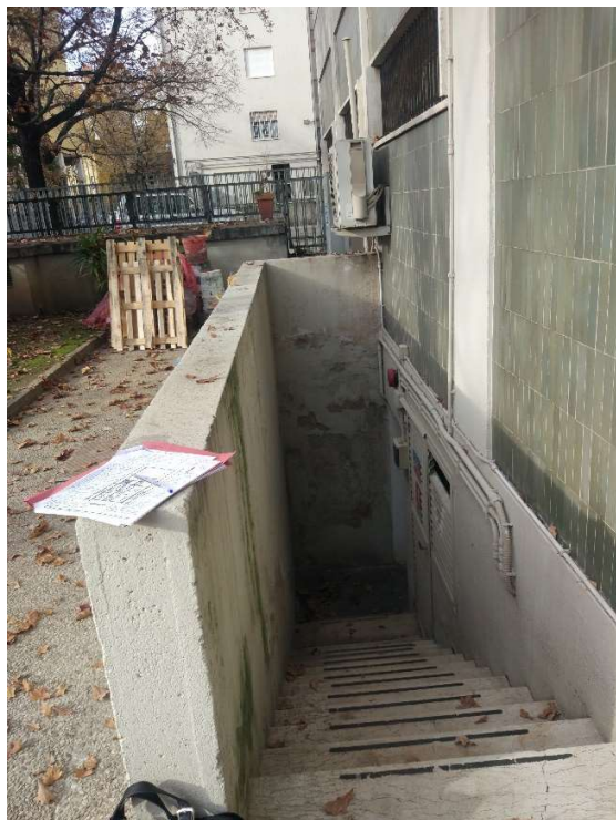
FOTO N. 5- accesso pedonale ai garage
