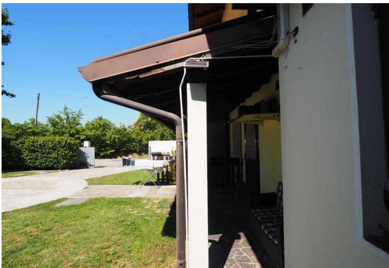
Porcia, via della Centa n. 3 – Il portico interno sul prospetto sud.
