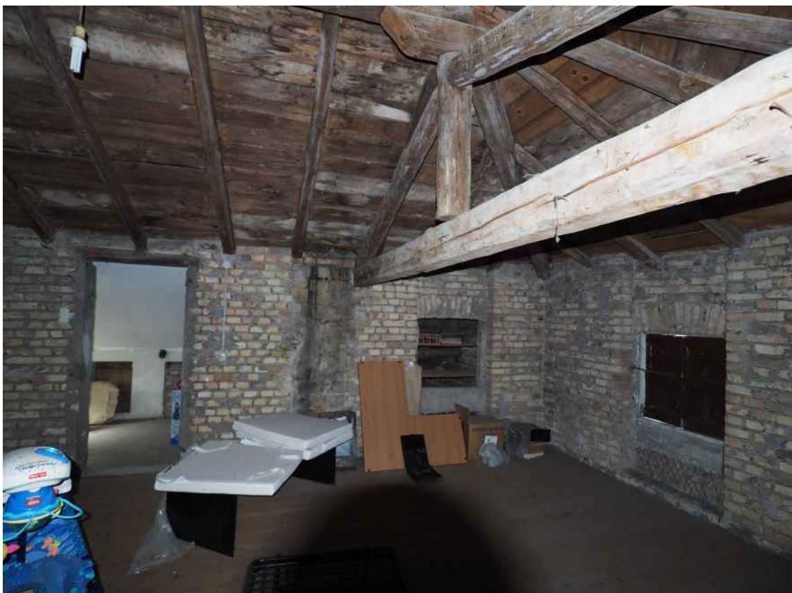
Porcia, via della Centa n. 3, P.II. - NCEU foglio 10, part. 19, sub. 8 – La soffitta.
