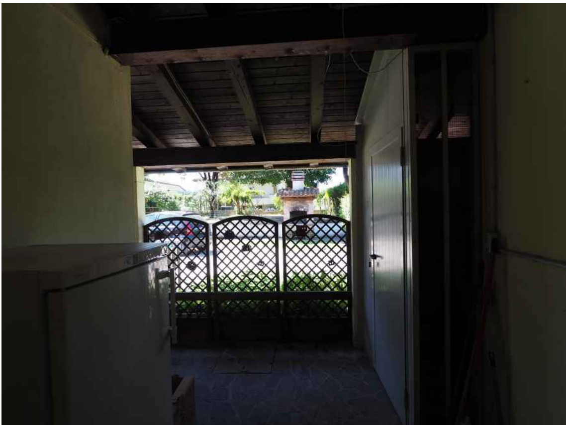
Porcia, via della Centa n. 3 – Il portico interno sul prospetto sud.
