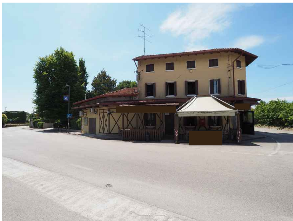
Porcia, via della Centa n. 1 e 3 – Sopra l'aerofotogrammetria, sotto il prospetto nord della palazzina.
