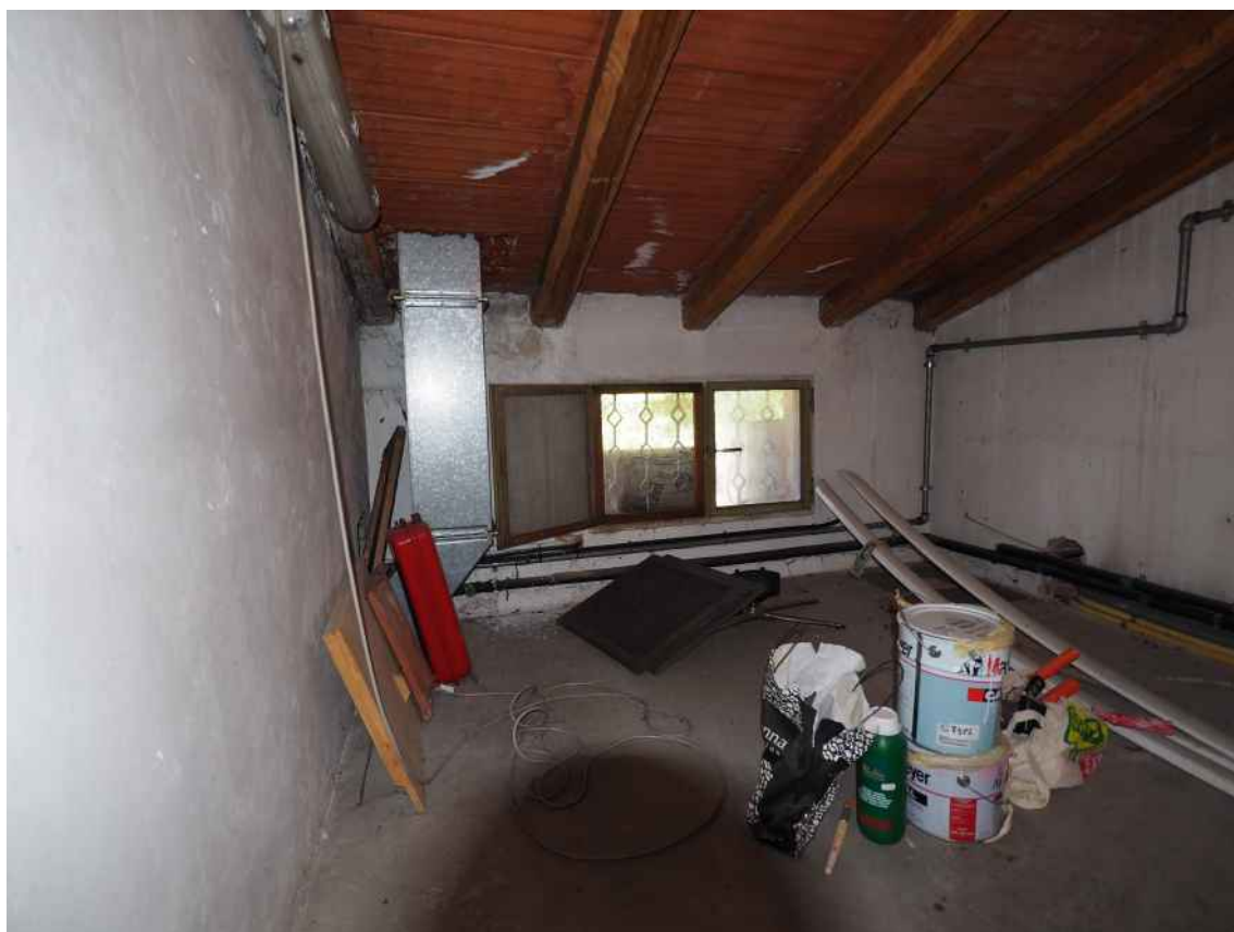
Porcia, via della Centa n. 3, P.I. - NCEU foglio 10, part. 19, sub. 8 – Sopra la soffitta, sotto il ripostiglio.
