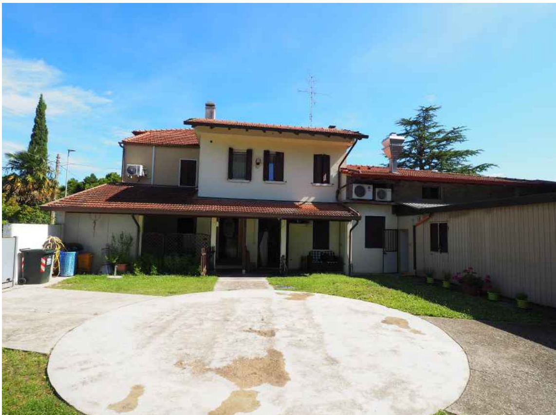
Porcia, via della Centa n. 1 e 3 – Il prospetto ovest e sud della palazzina.
