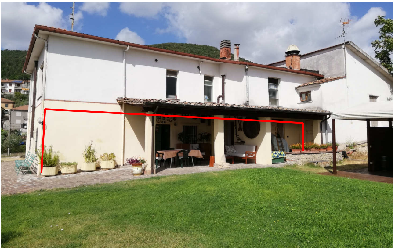
4) Prospetto lato sud-est (il portico ricade su u.i. sub 11)
