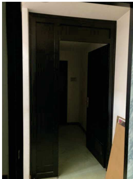
vista disimpegno al piano seminterrato
