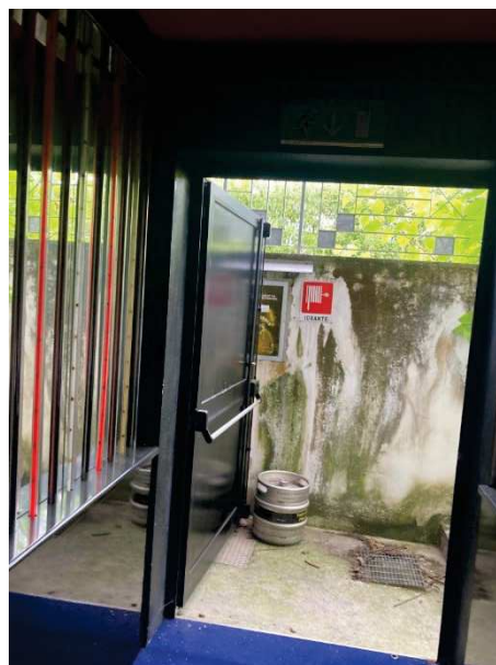
vista uscita di emergenza lato Ovest
