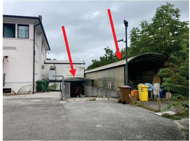
particolare delle due tettoie abusive lato Sud
