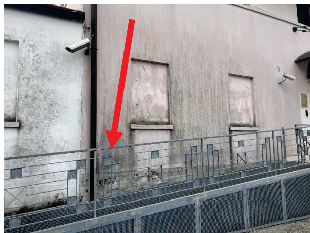
particolari degrado muratura esterna
