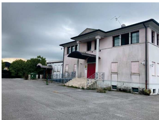
prospetto principale lato Nord
