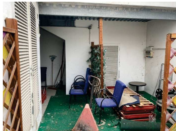
particolare ingresso magazzino sub. 14
