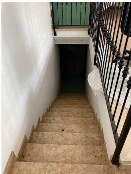
vano scala interno posto a Sud del fabbricato di collegamento tra piano rialzato e seminterrato
