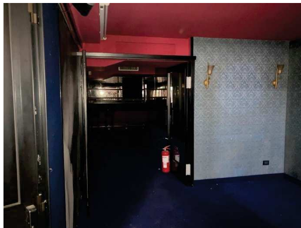
particolare corridoio in prossimità dell'uscita di emergenza al piano seminterrato
