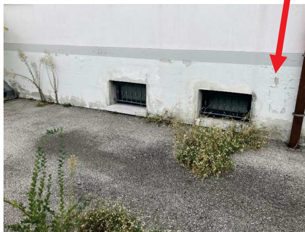
particolari degrado muratura esterna
