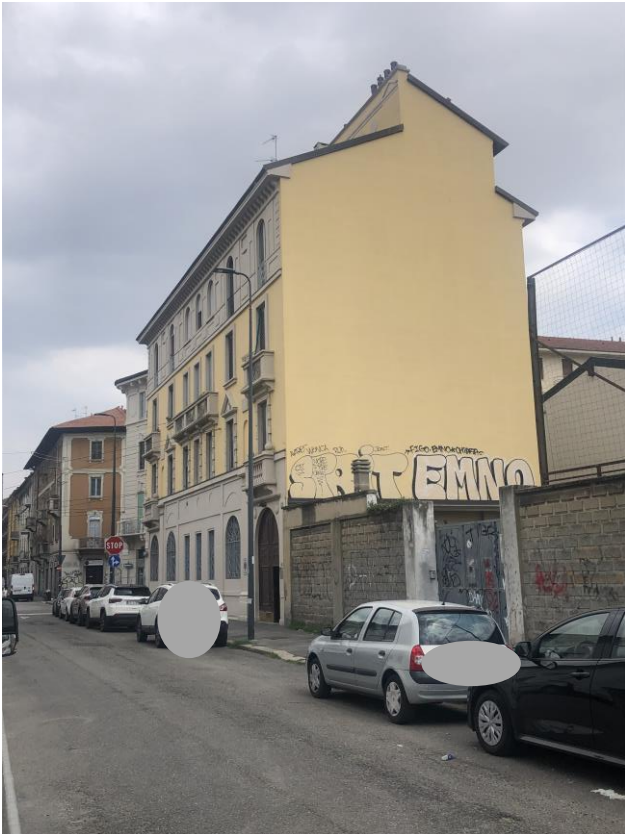
Vista del fabbricato da Via Mercantini
