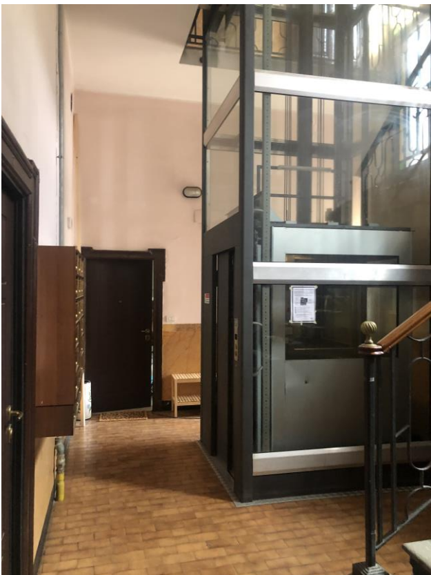
Vista vano ascensore
