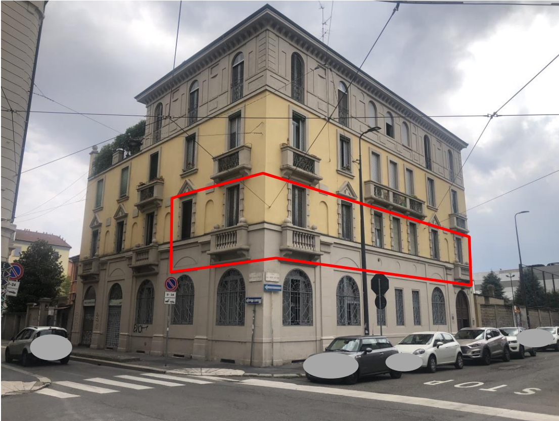
Vista del fabbricato da Via Mercantini angolo Via Varè
