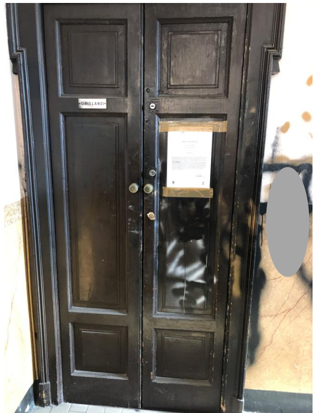
Vista porta di ingresso al 26.01.2024
