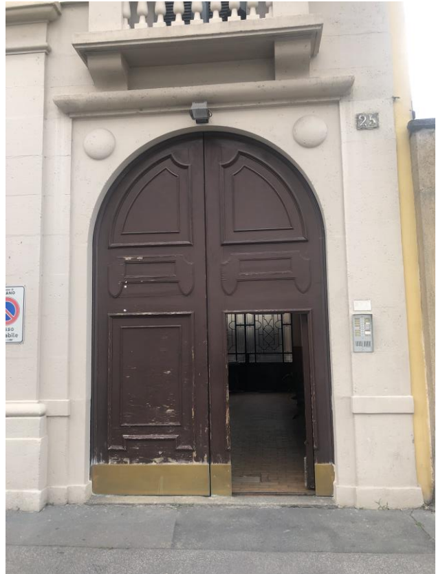
Vista portone di ingresso allo stabile
