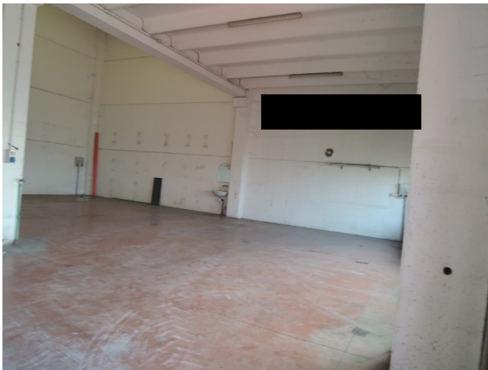
Foto 3 – magazzino piano terra (corpo A)
