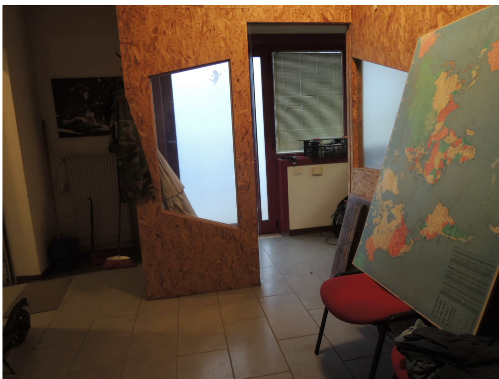
Foto 8 – ufficio piano terra (corpo A)
