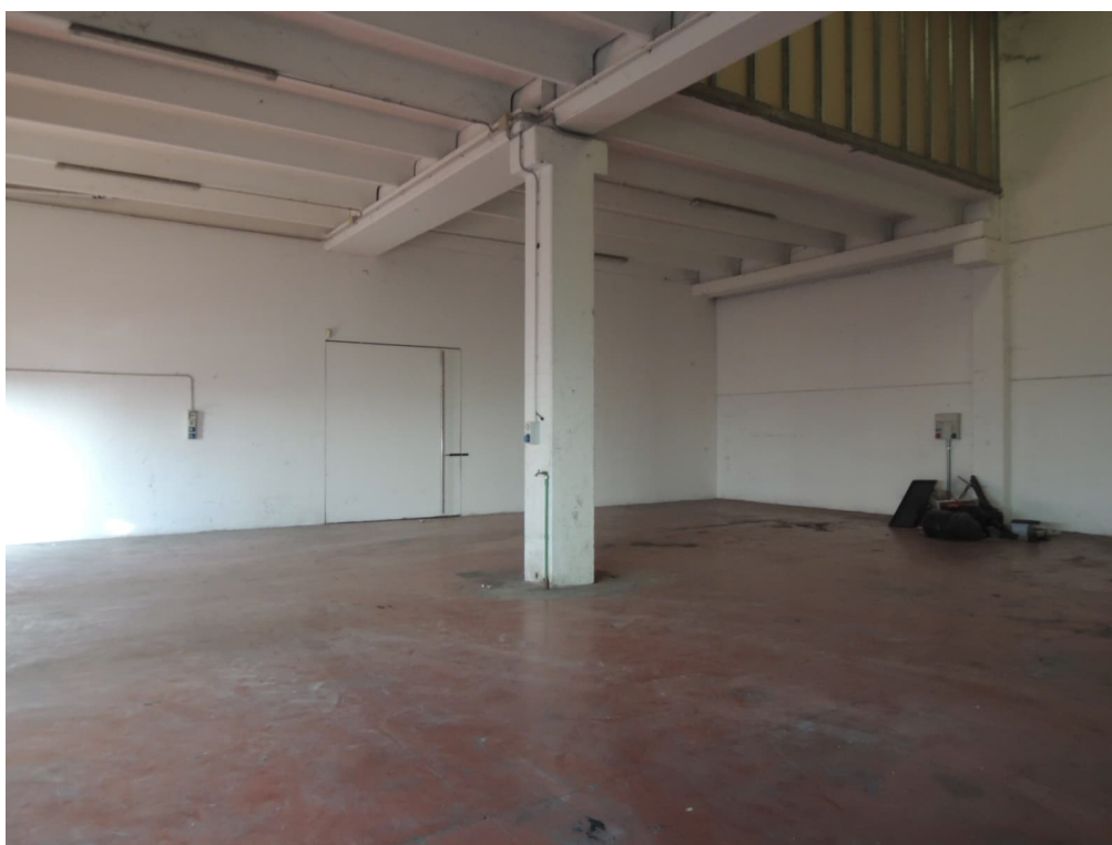
Foto 4 – magazzino piano terra (corpo A)
