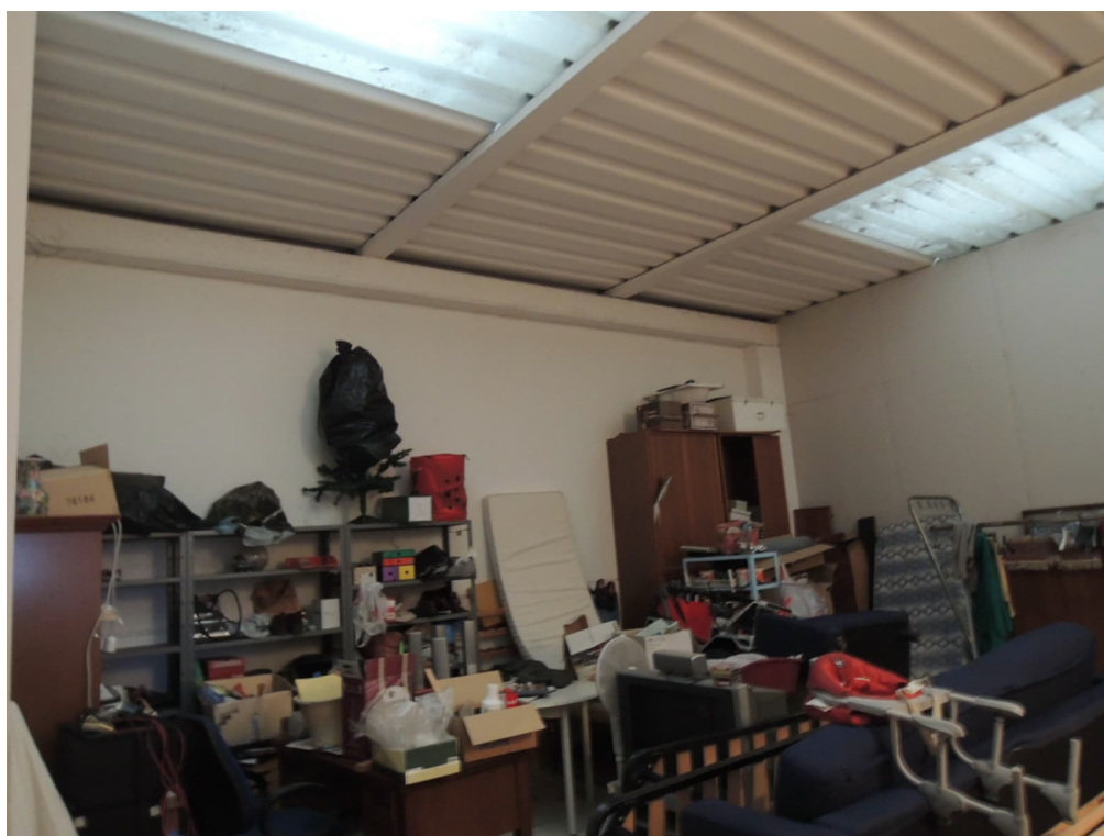
Foto 10 – magazzino piano primo (corpo A)
