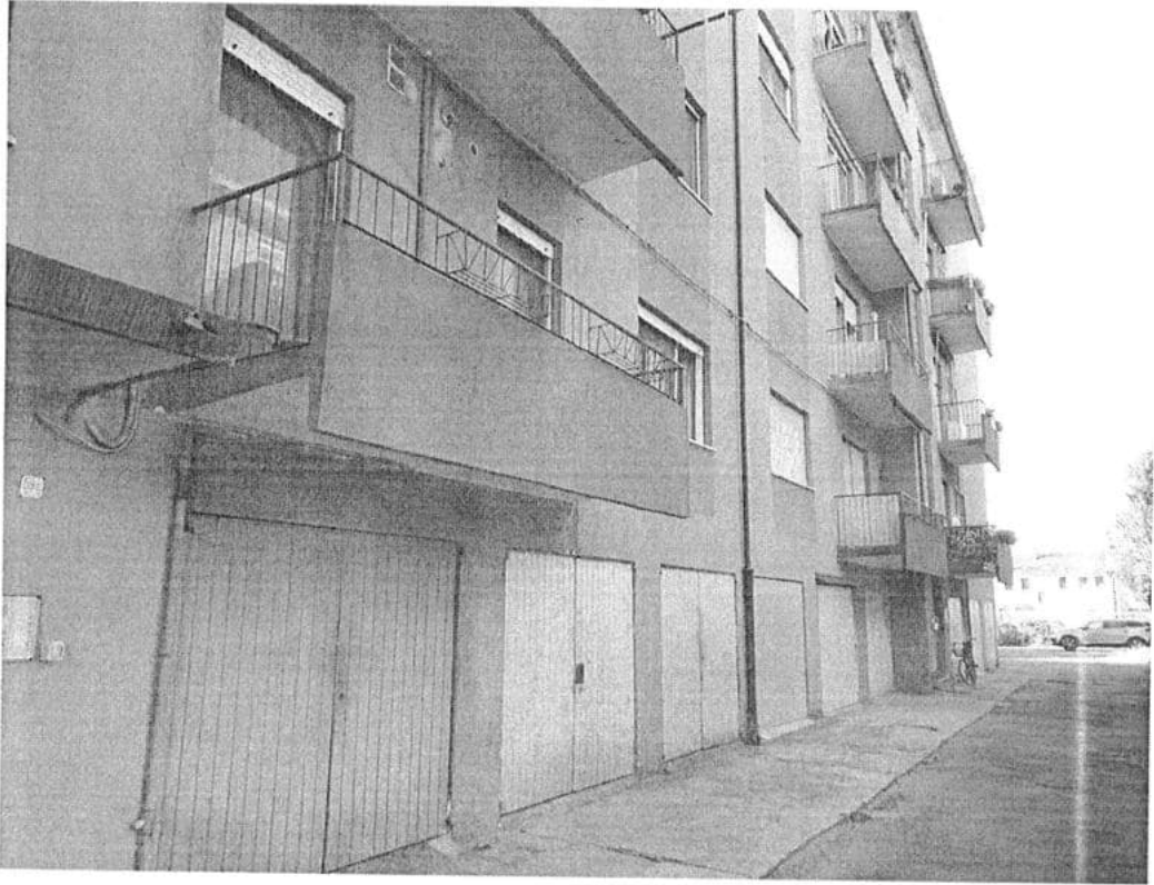
Foto 1 Scorcio del condominio in Venezia Via Castellana.
