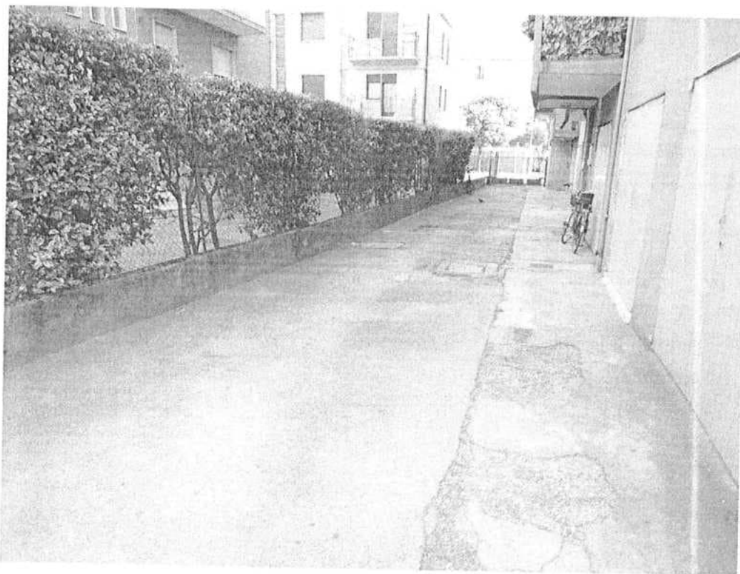
Foto 13 Vista dell'area scoperta.
