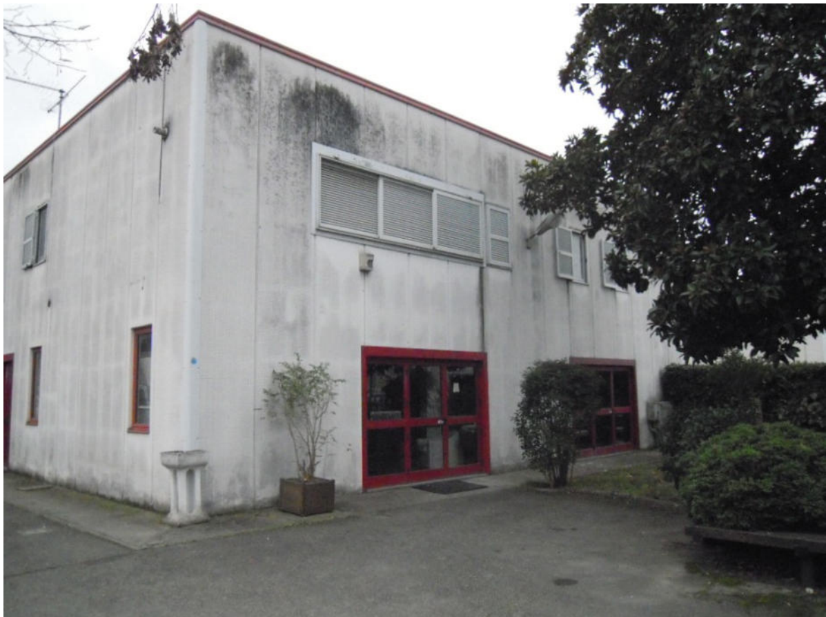
vista ingresso della sala esposizione (sub.2)
