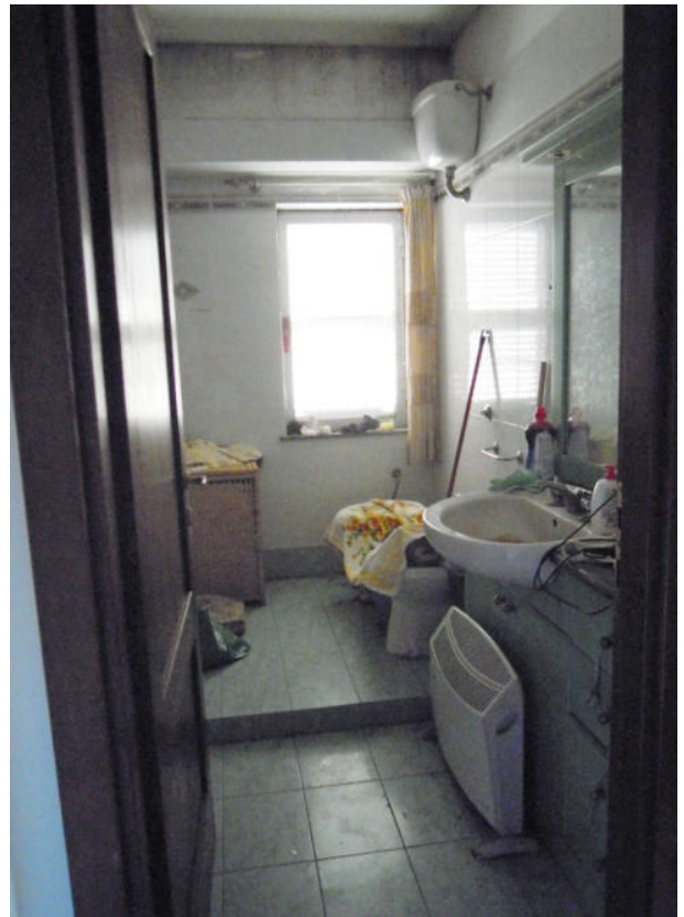
vista del servizio igienico 2
