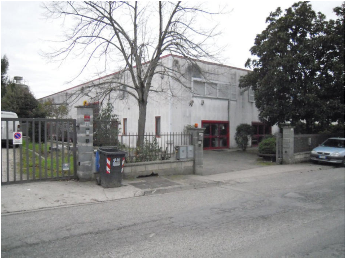
Vista ingresso da Via delle Acacie
