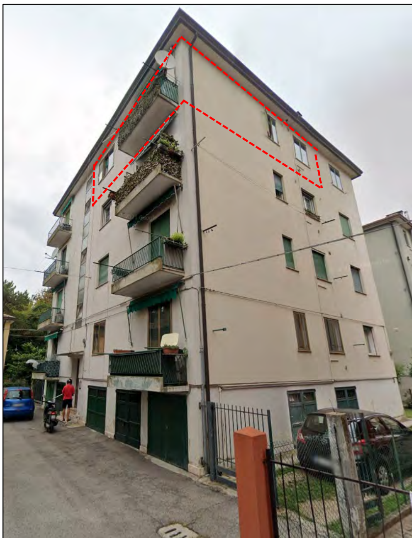
Foto 1 – esterno lato SUD-EST
