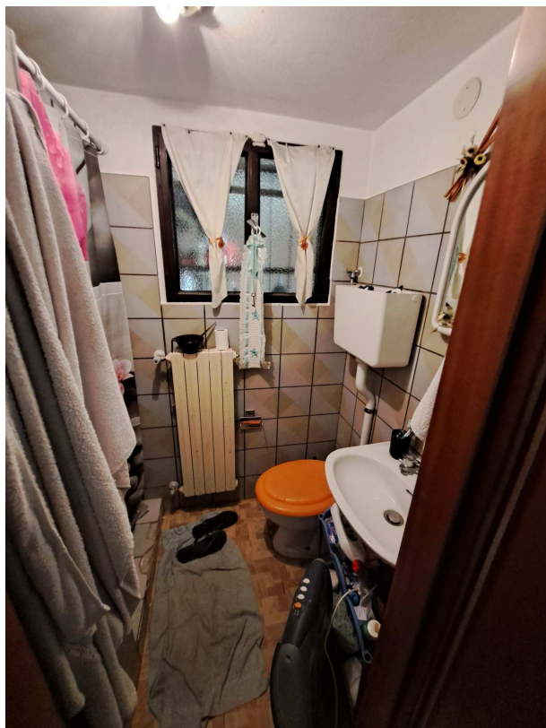
Foto n. 12: vista del locale bagno ricavato nel garage, da demolire
