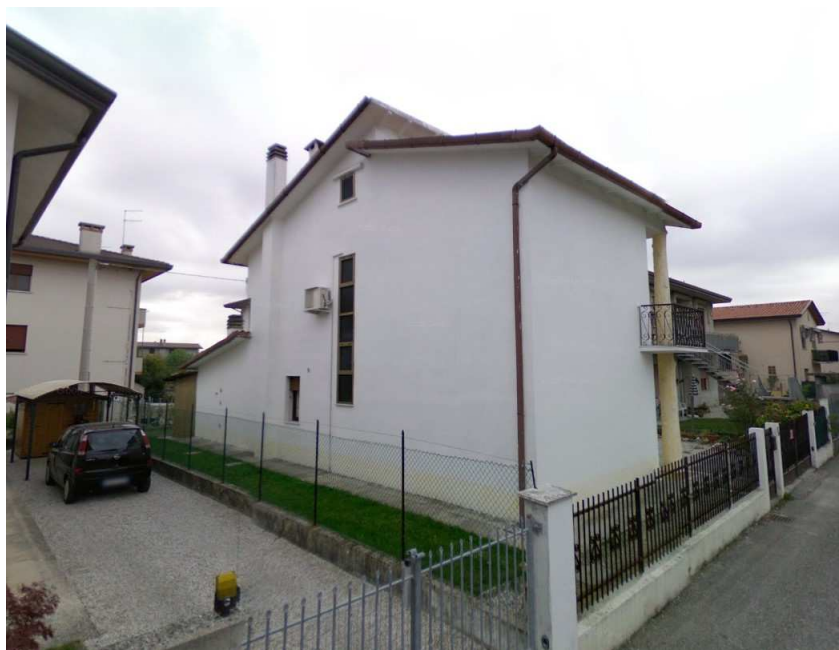
Foto n. 3: Vista da Nord-Ovest del fabbricato oggetto di pignoramento.
