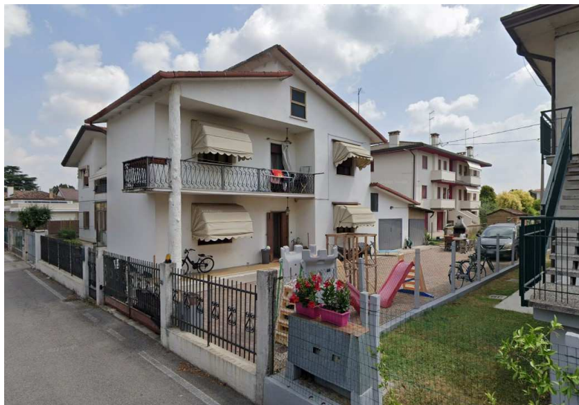
Foto n. 1: Vista da Sud-Ovest del fabbricato oggetto di pignoramento.
