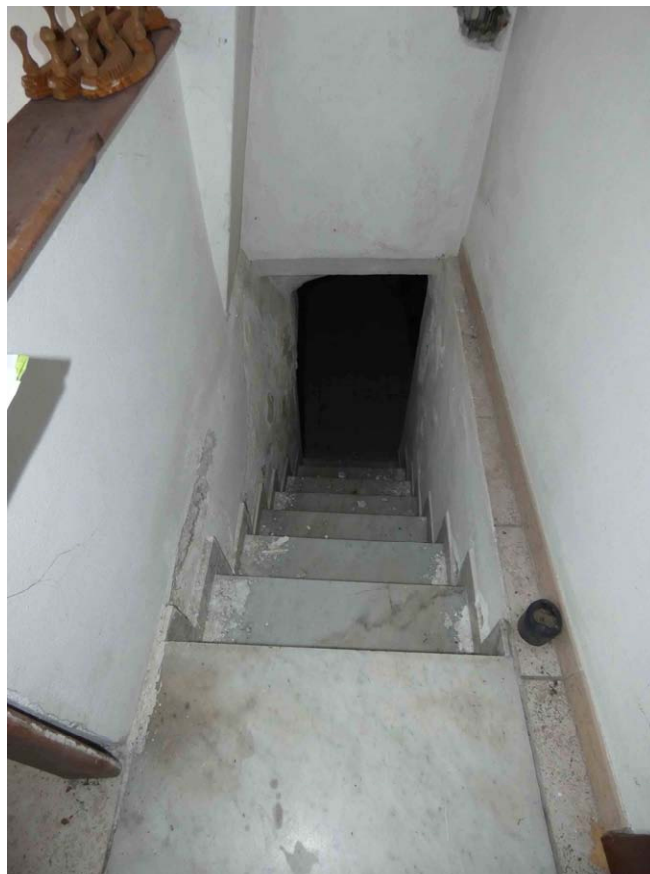
Foto 13. Scala d'accesso al piano interrato
