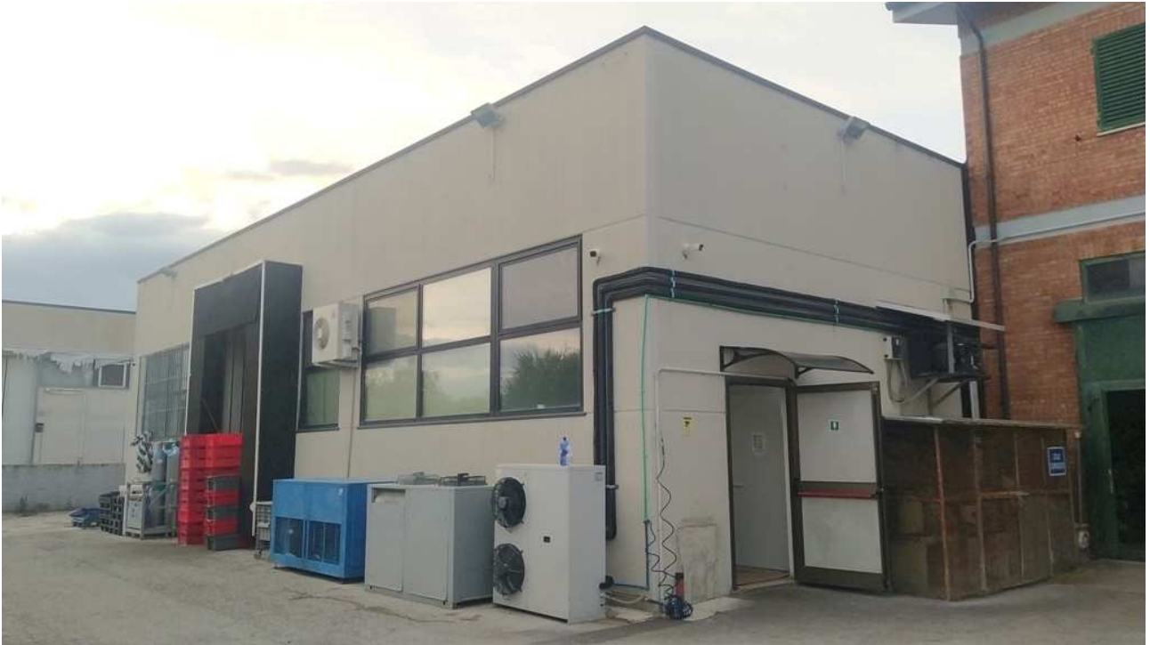
Parete posteriore dell'edificio destinato a laboratorio e magazzino
