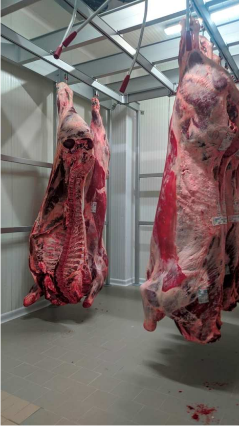
Celle frigorifera immagine all'interno della cella
