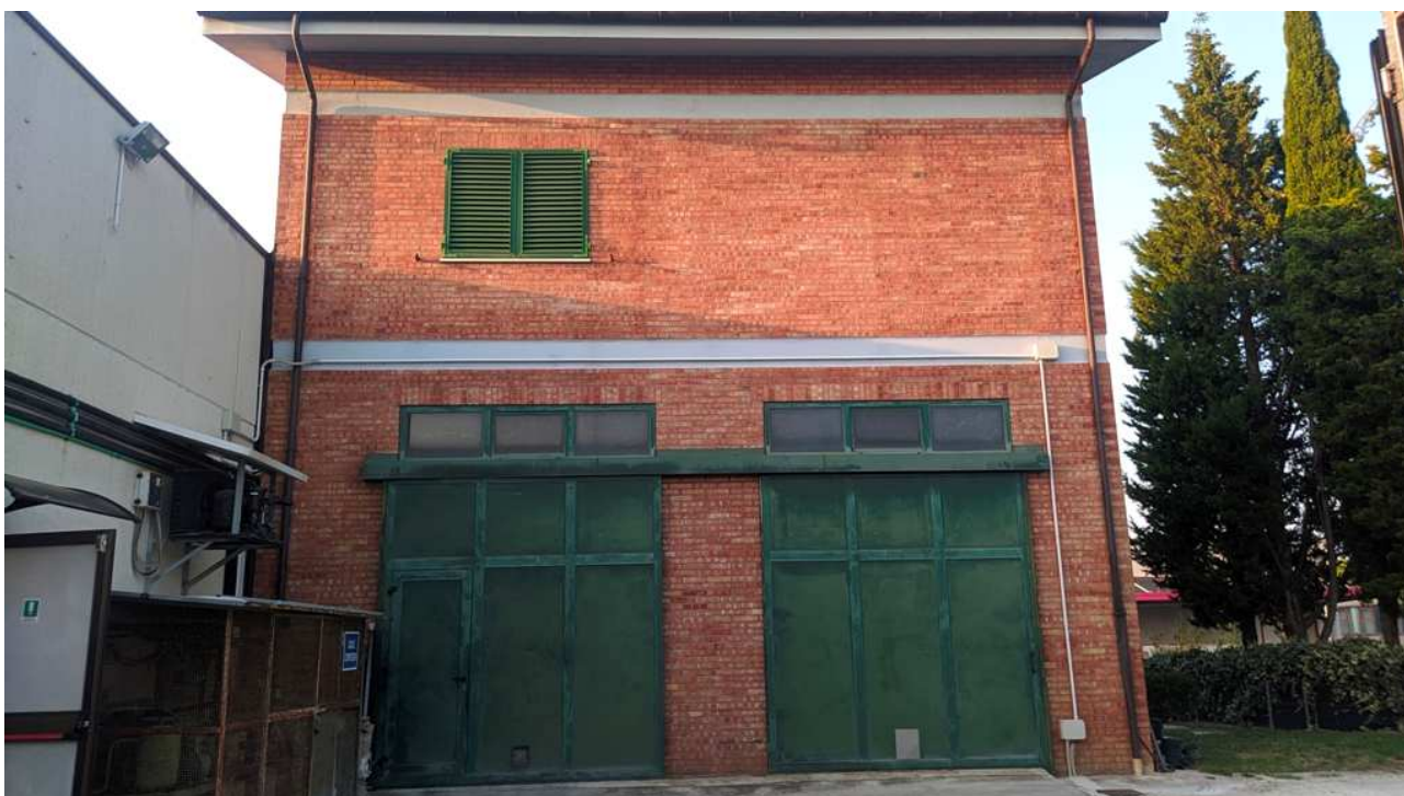
Autorimessa con accesso carrabile dal retro dell'edificio
