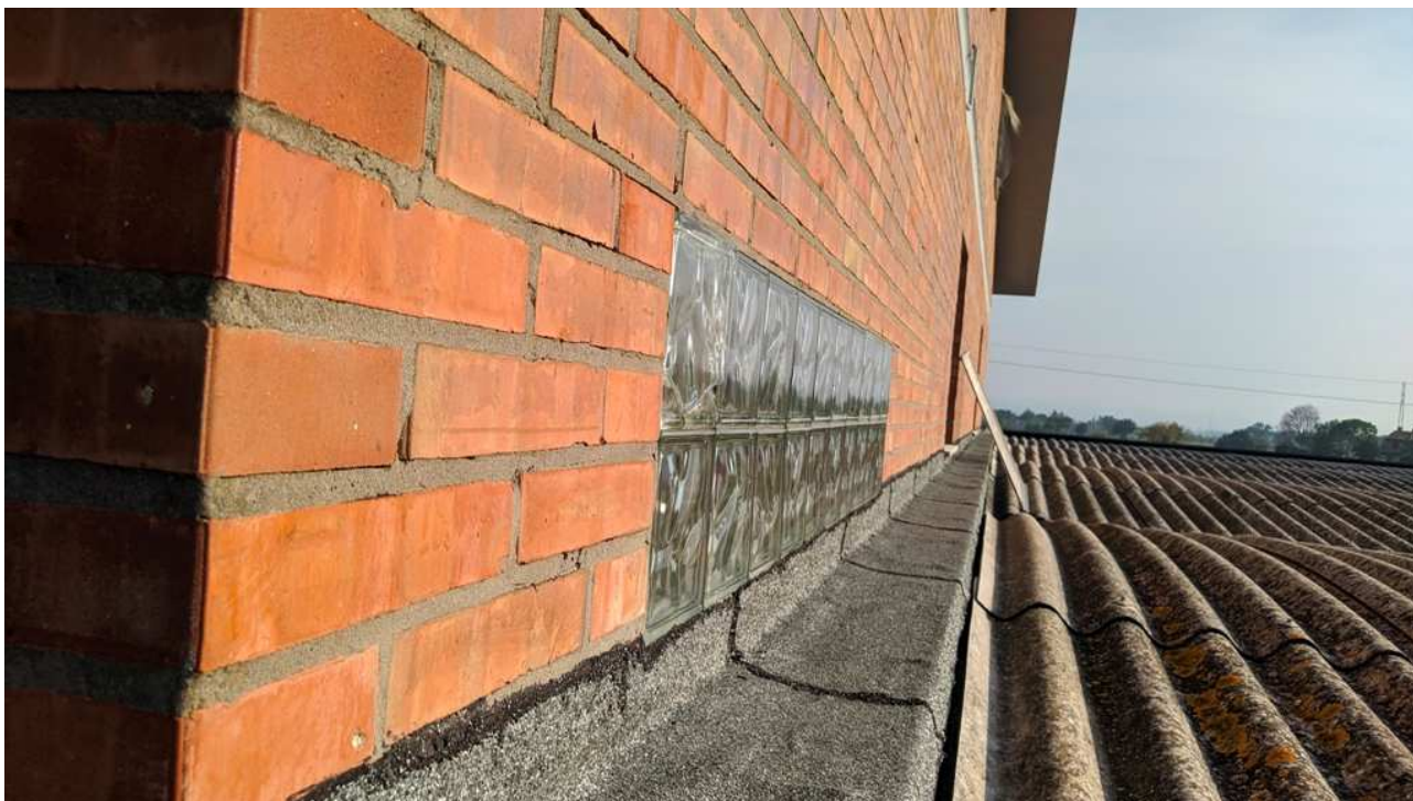
Pareti esterne: mattoncini, vetrocimento guaina e affaccio su copertura in lastre di eternit del capannone
