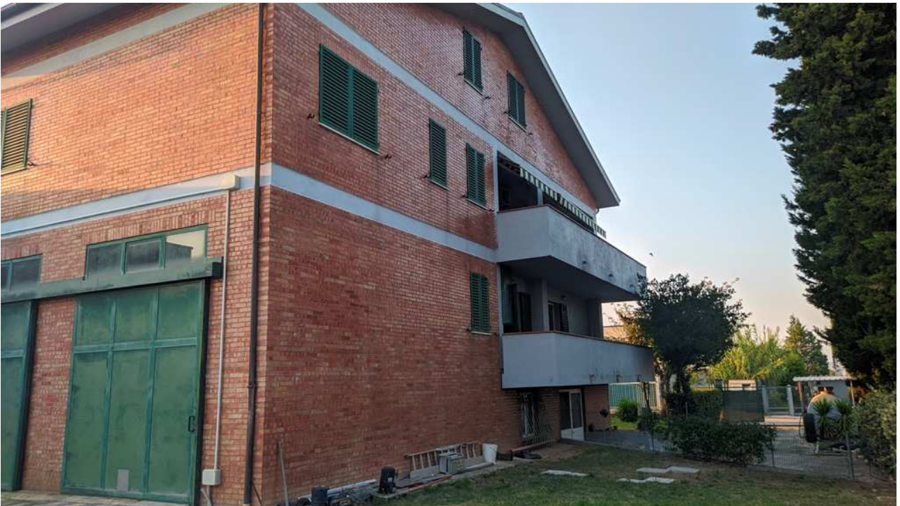
Vista laterale nella zona dell'autorimessa
