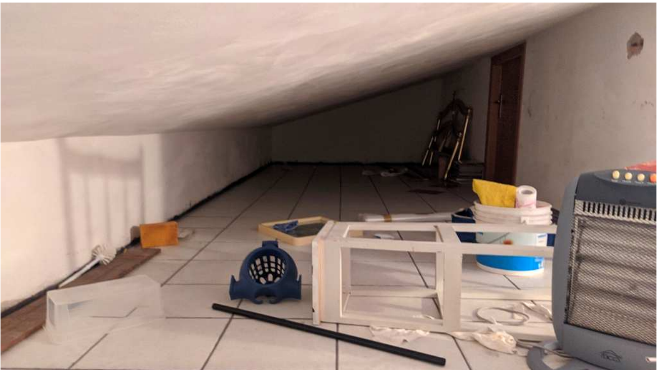
Locali ad altezza ridotta, sotto alla copertura, utilizzati come ripostiglio
