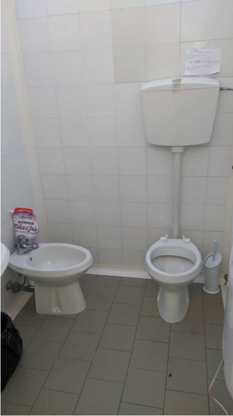
Locale bagno per i dipendenti
