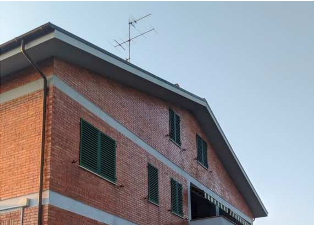
Appartamento al piano terzo, sottotetto
