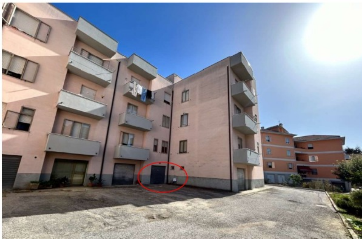
Prospetto N/W in evidenza l'autorimessa a servizio dell'abitazione
