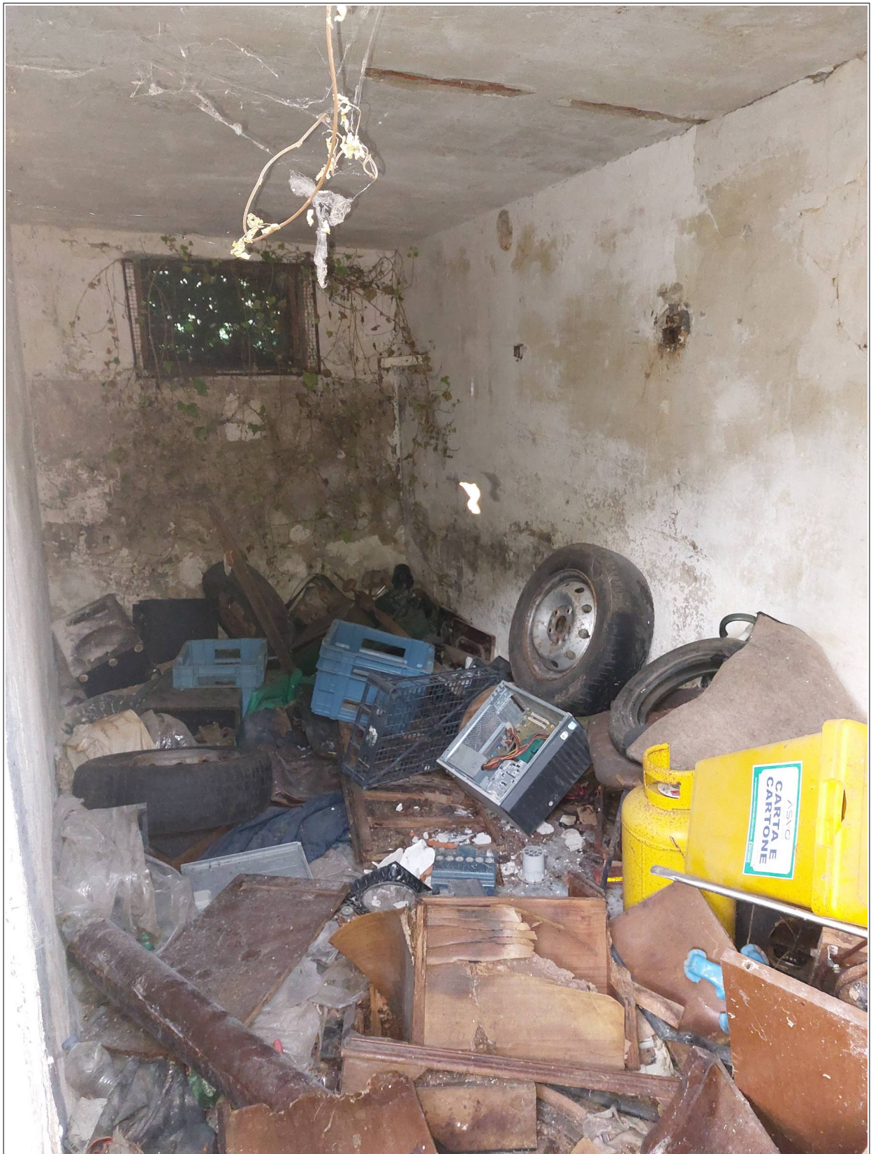
Foto n° 24 - Comune di Annone Veneto, foglio 1, part.811, sub.3 – Stanza catastalmente identificata come ripostiglio.
