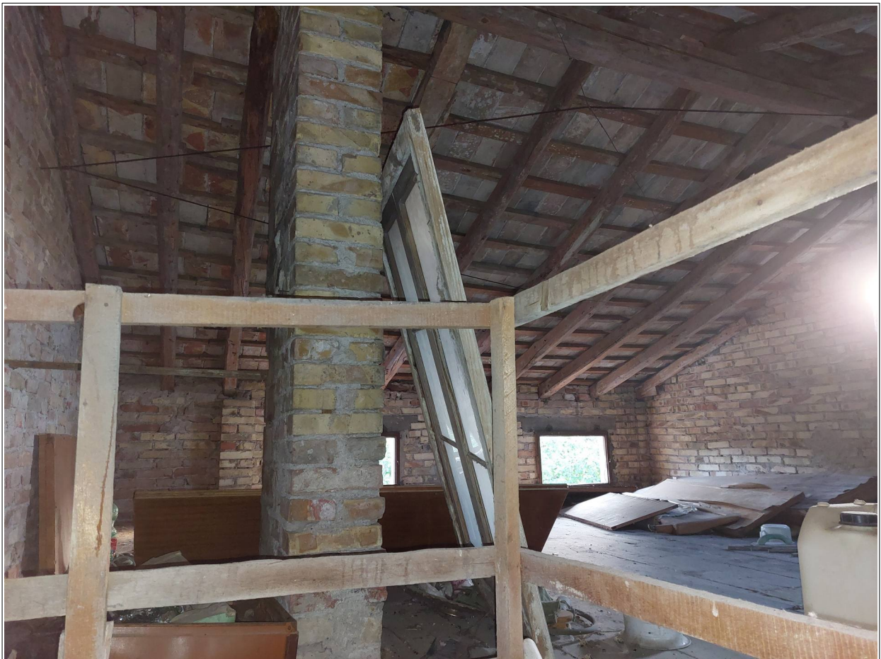
Foto n° 21 - Comune di Annone Veneto, foglio 1, part.1032 – Piano terzo. Soffitta.
