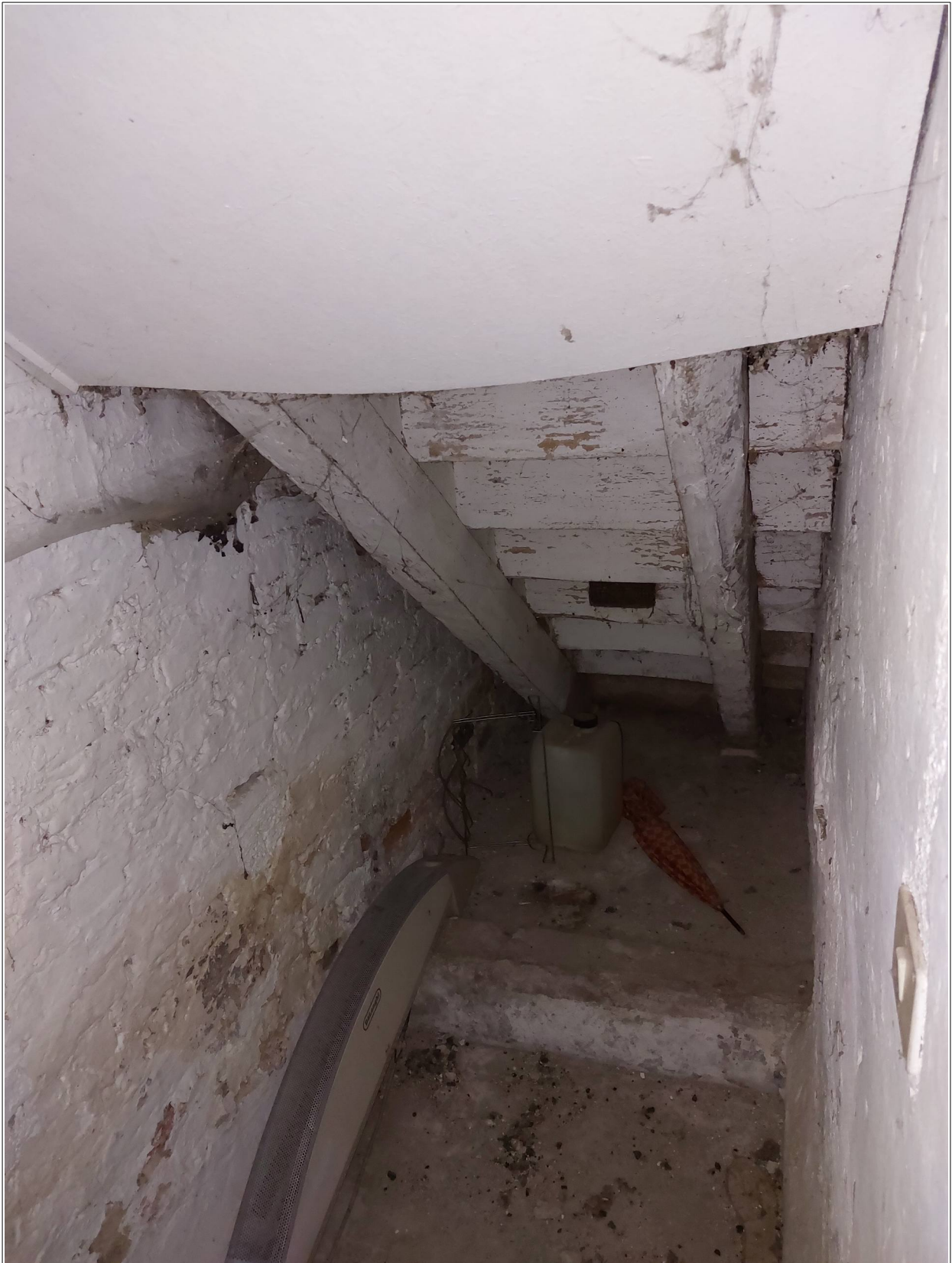
Foto n° 7 - Comune di Annone Veneto, foglio 1, part.1032 – Piano terra. Rispostiglio.
