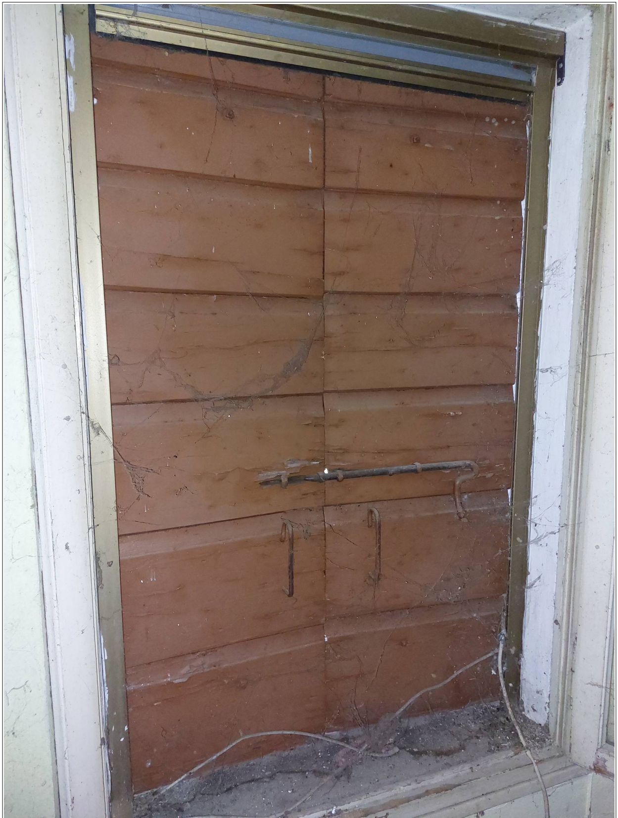
Foto n° 4 - Comune di Annone Veneto, foglio 1, part.1032 – Piano terra. Particolare dei serramenti esterni del soggiorno.
