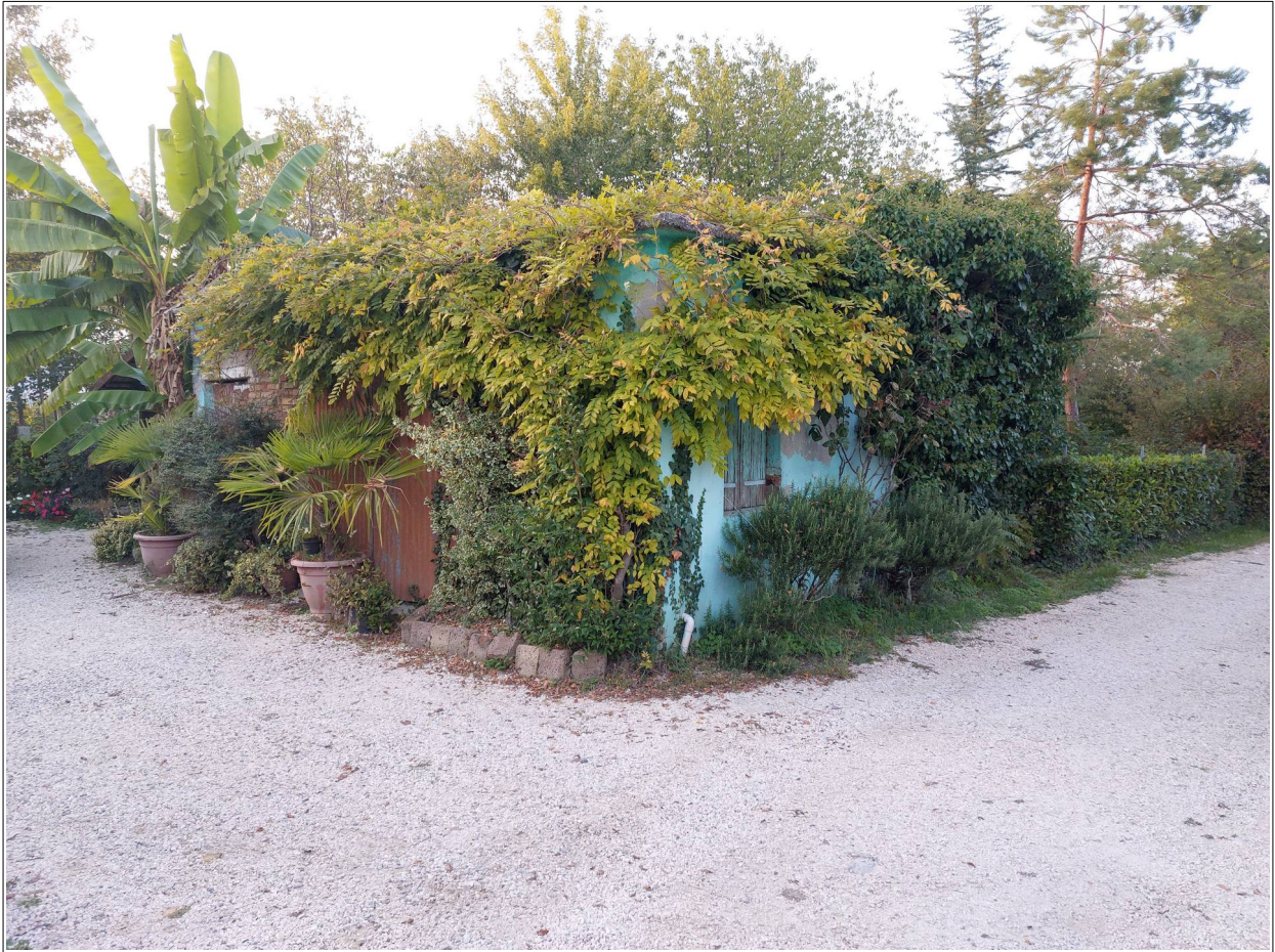
Foto n° 23 - Comune di Annone Veneto, foglio 1, part.811, sub.3 – Visione esterna del fabbricato pignorato.
