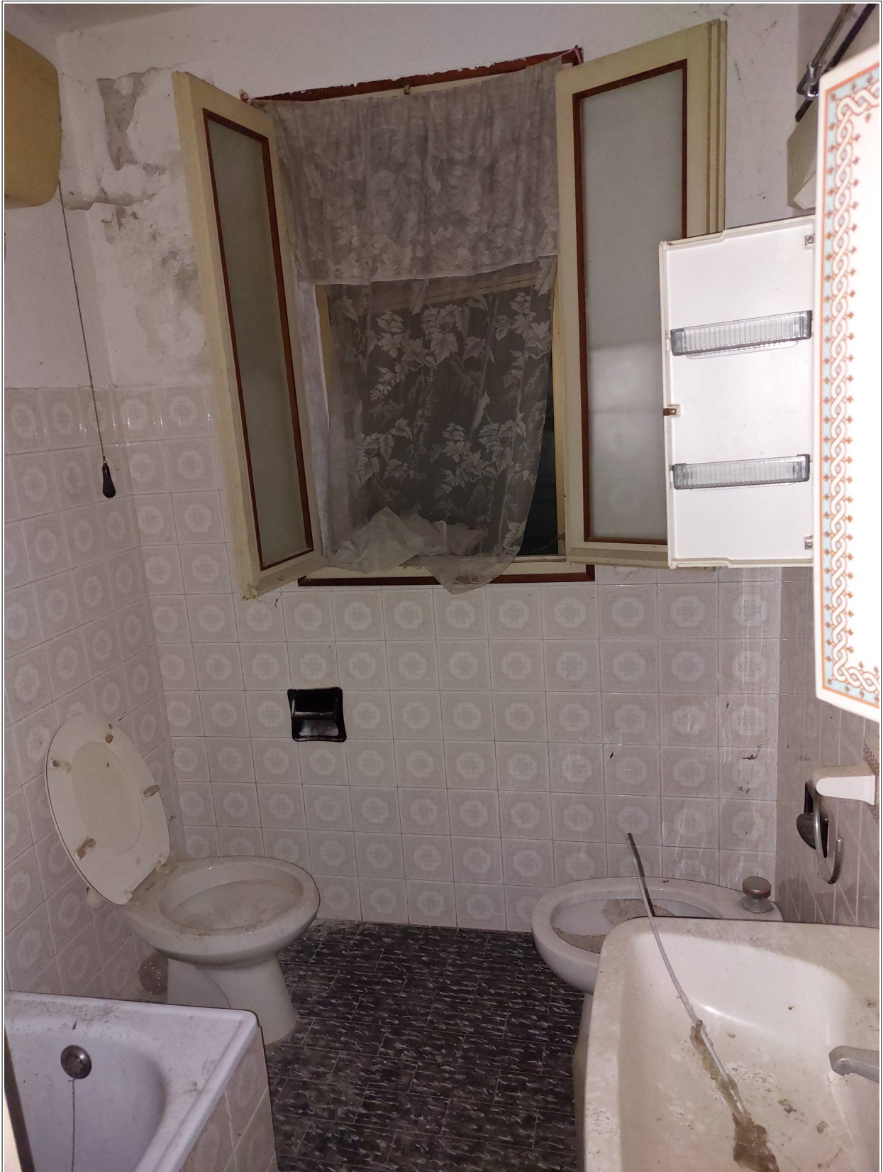
Foto n° 9 - Comune di Annone Veneto, foglio 1, part.1032 – Piano terra. Bagno.
