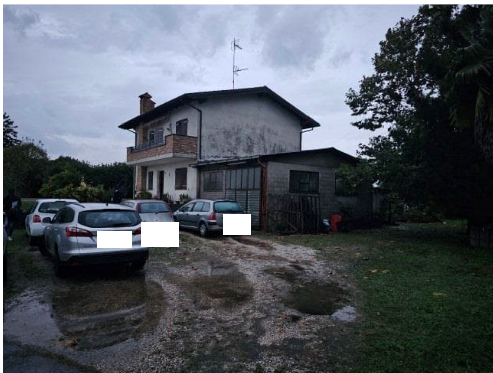
FOTO 2: ALTRA PANORAMICA DEL FABBRICATO
