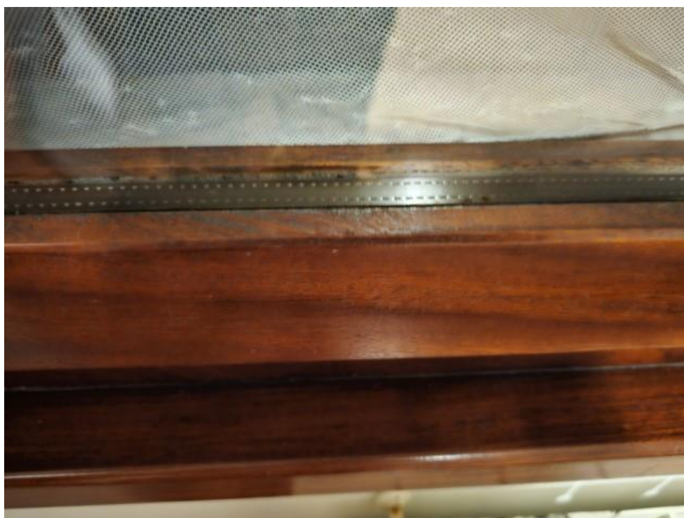
FOTO 18: PARTICOLARE SERRAMENTO (SUB. 4 – 1°P.)
