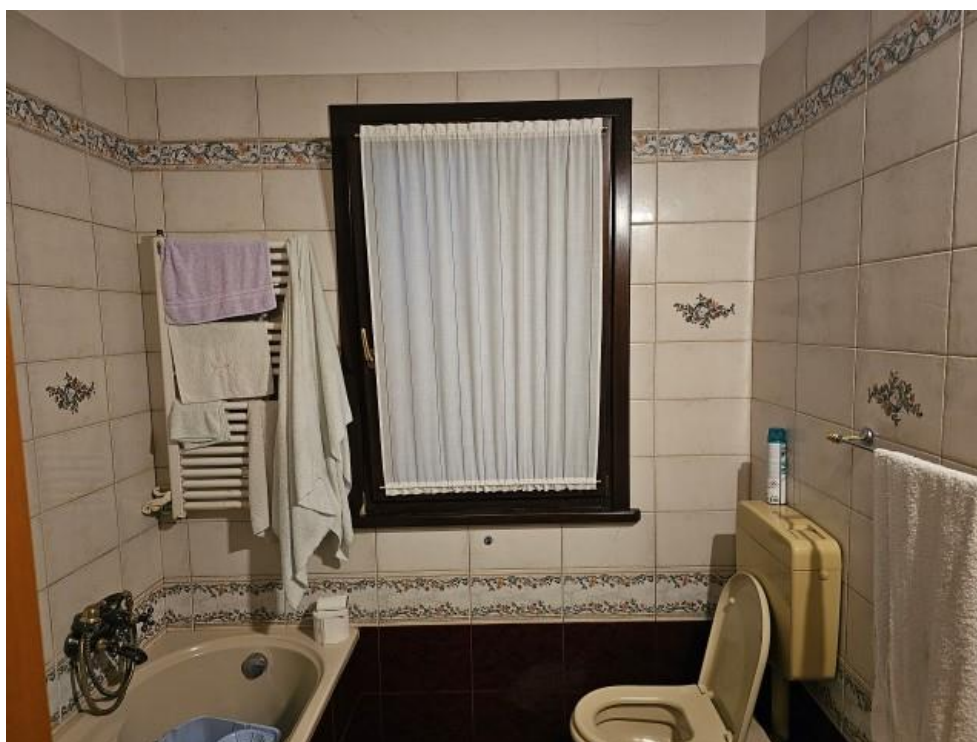
FOTO 16: BAGNO (SUB. 4 – 1°P.)
