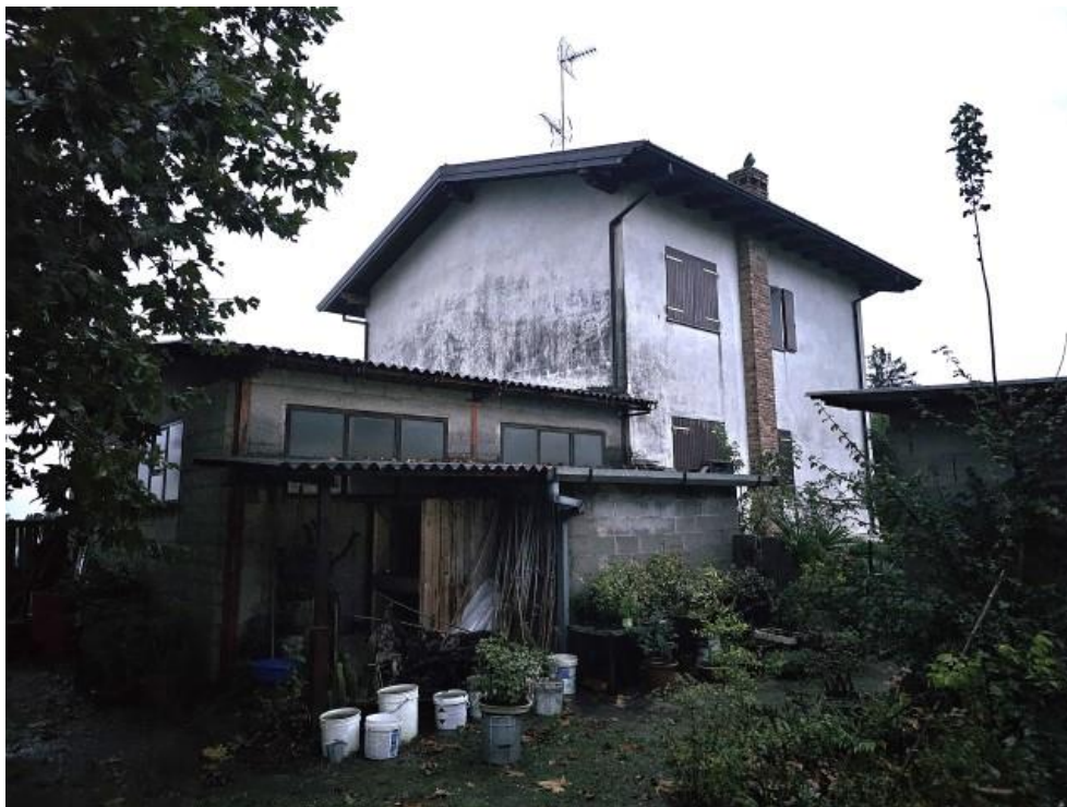
FOTO 3: ALTRA PANORAMICA DEL FABBRICATO
