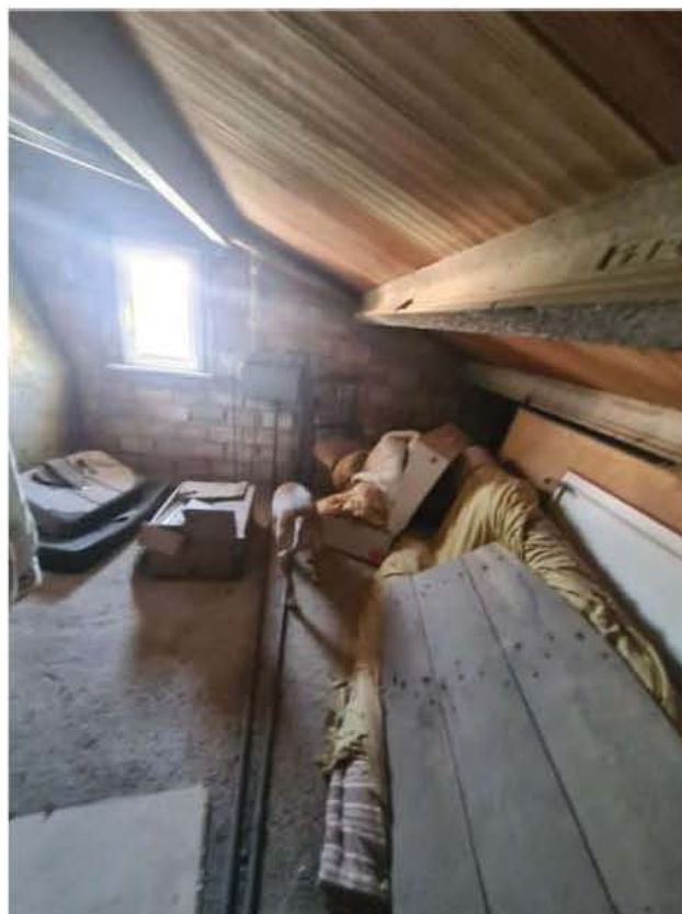
Foto 12: Interno piano secondo: soffitta
