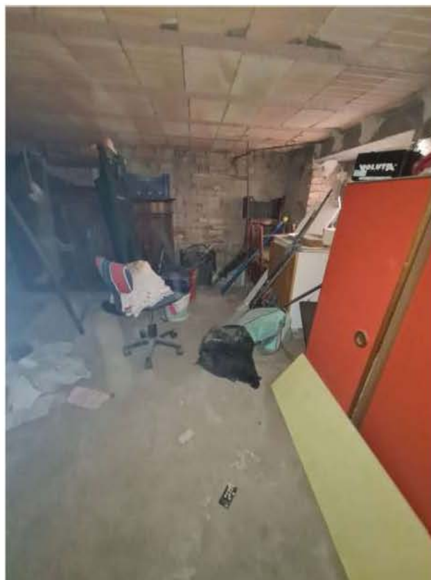
Foto 4: Interno piano seminterrato: ripostiglio
