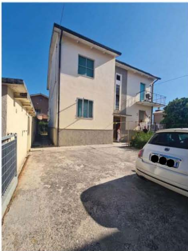
Foto 1: Vista prospetto Sud
