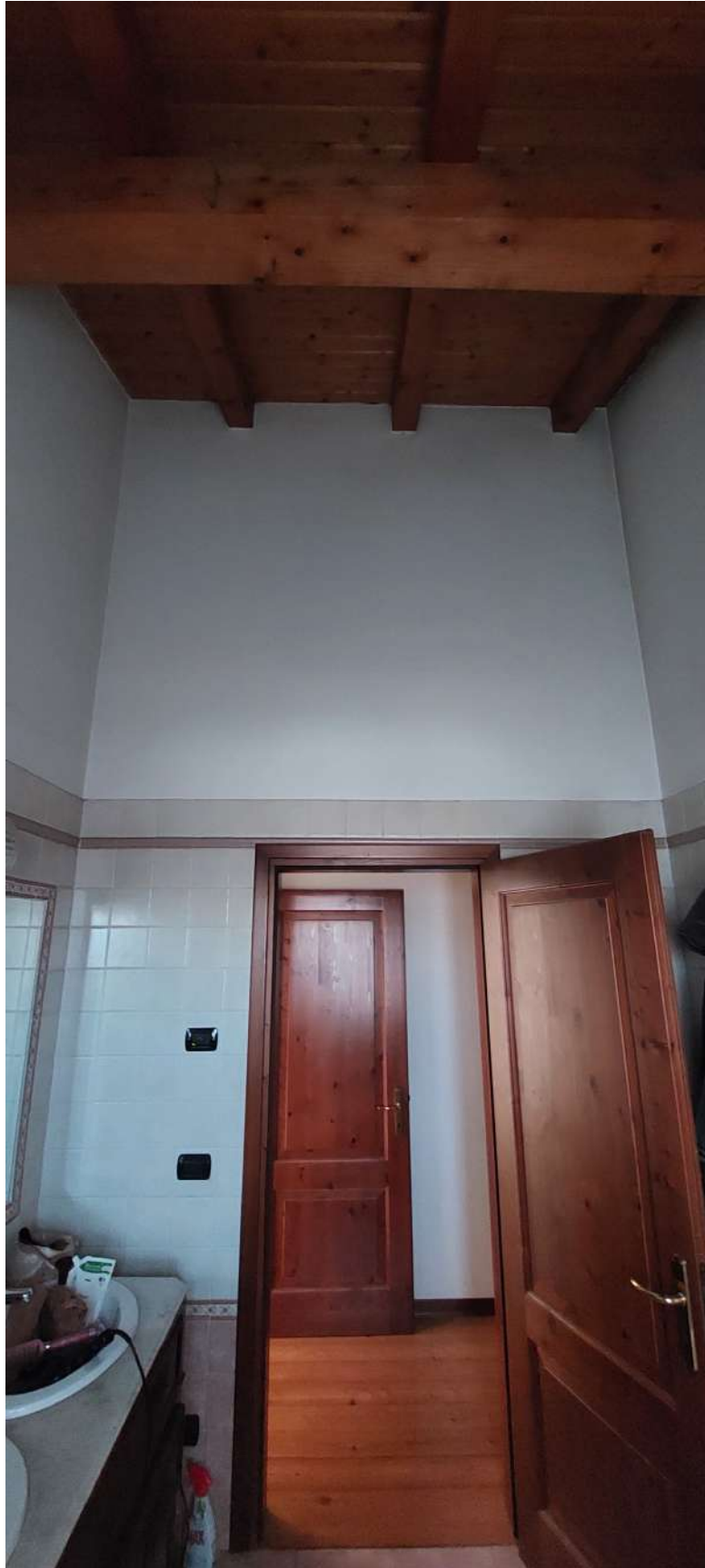
Bagno al Piano Primo
