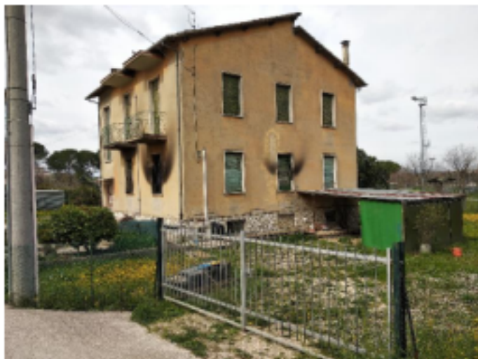
Vista esterna – angolo E
