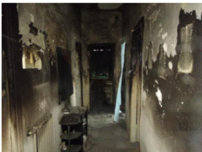
Appartamento p.rialzato - corridoio
