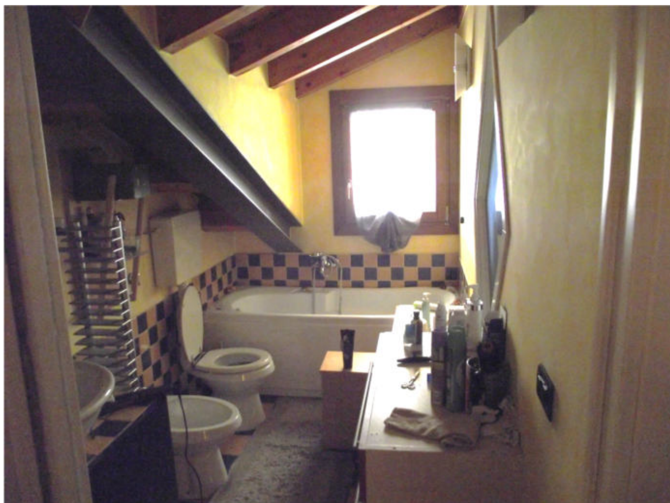
Foto 14 – Bagno nel sottotetto (abusivo)
