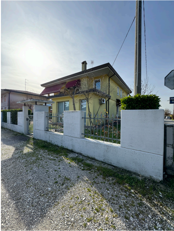
1. Vista esterna fabbricato
