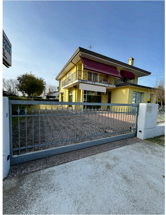
2. Vista esterna fabbricato
