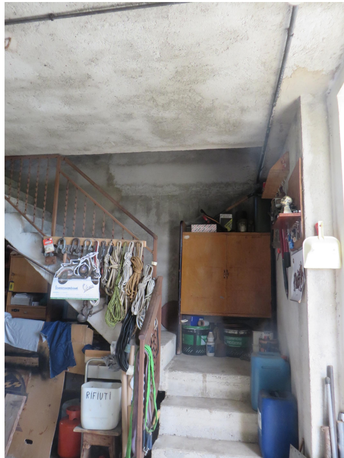
Foto magazzini situati al piano terra – Bene n. 7
