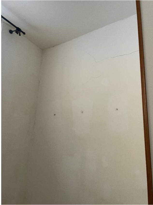
Particolare della parete adiacente all'infisso del locale posteriore
