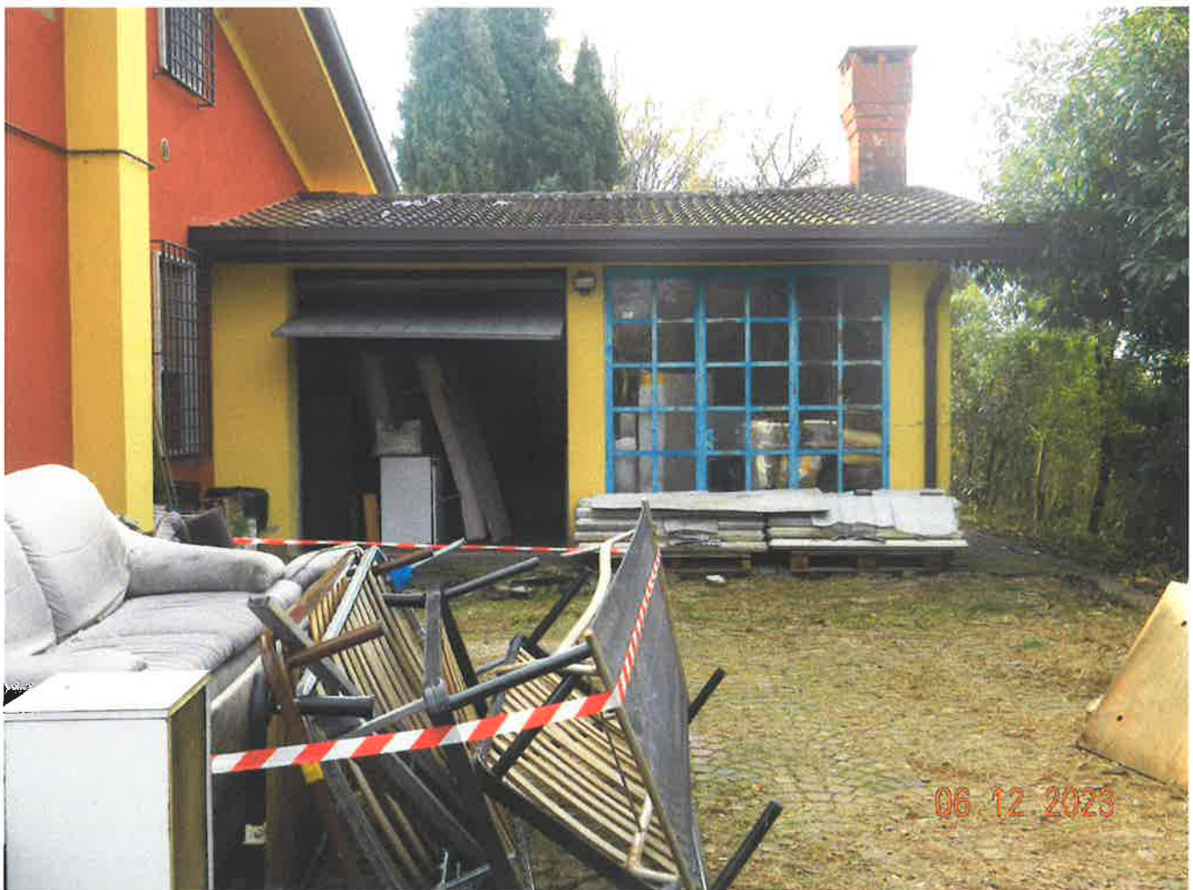
LOTTO 3 - Autorimessa - vista esterna
