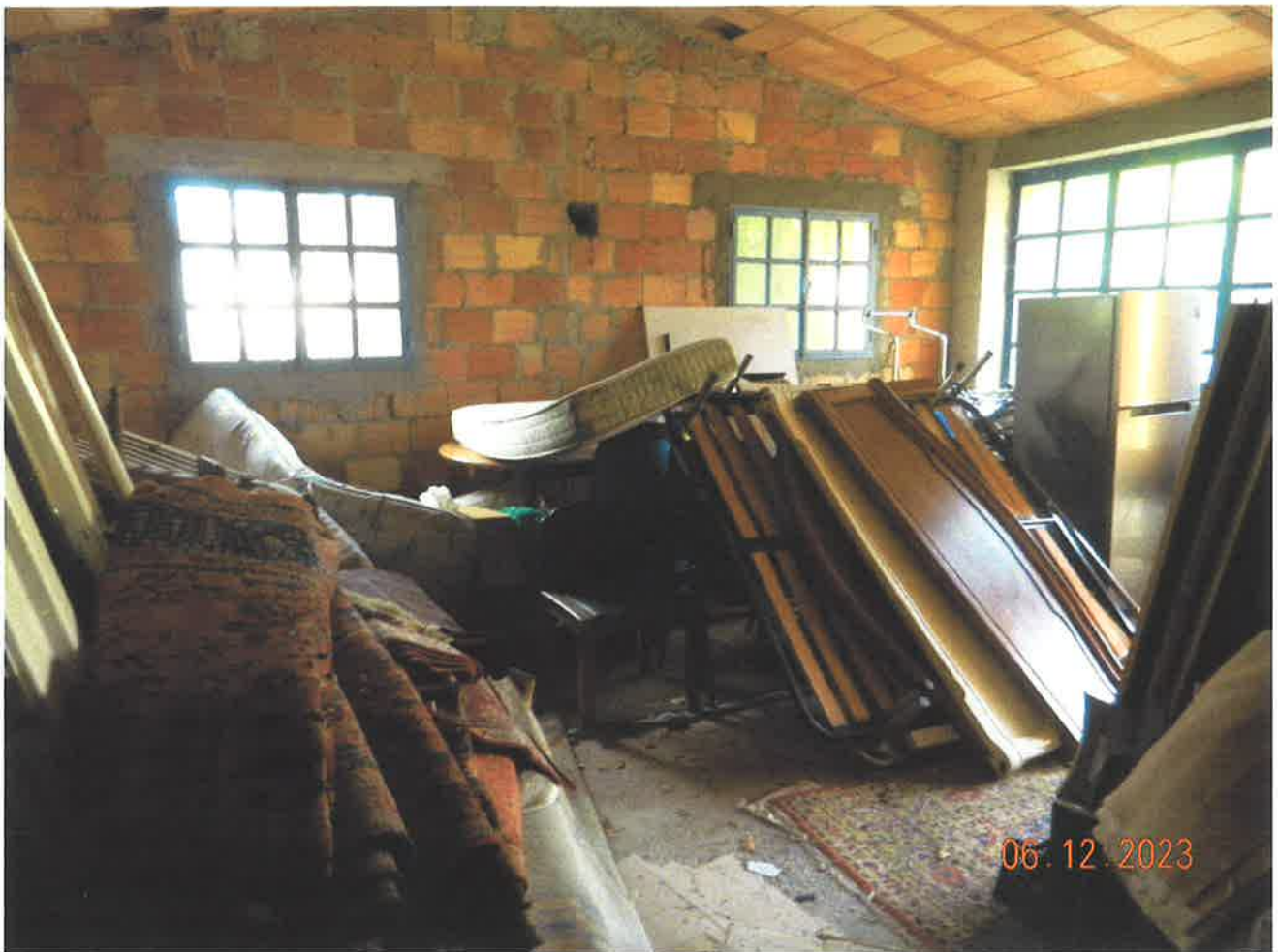
LOTTO 3 - Autorimessa - vista interna
