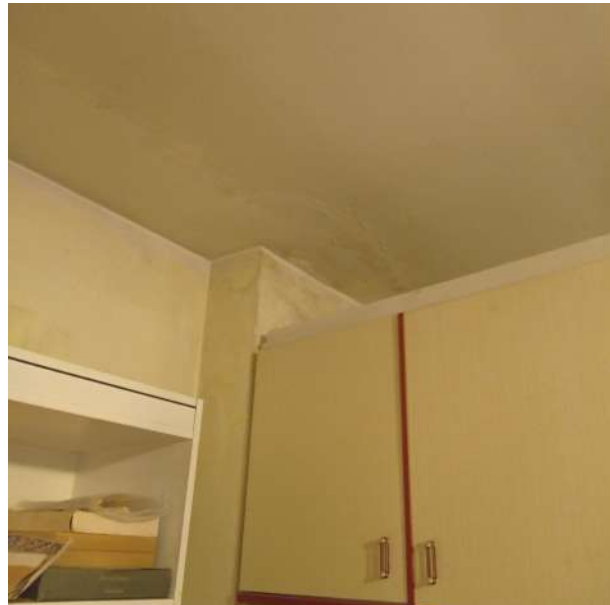
Foto n. 50-51: vista della camera da letto 1 e dettaglio delle infiltrazioni provenienti dal lastrico della copertura piana.
