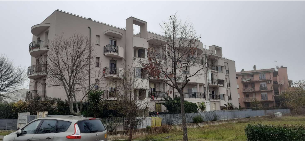
FOTO 1_ VISTA ESTERNA FABBRICATO RESIDENZIALE LATO NORD OVEST
