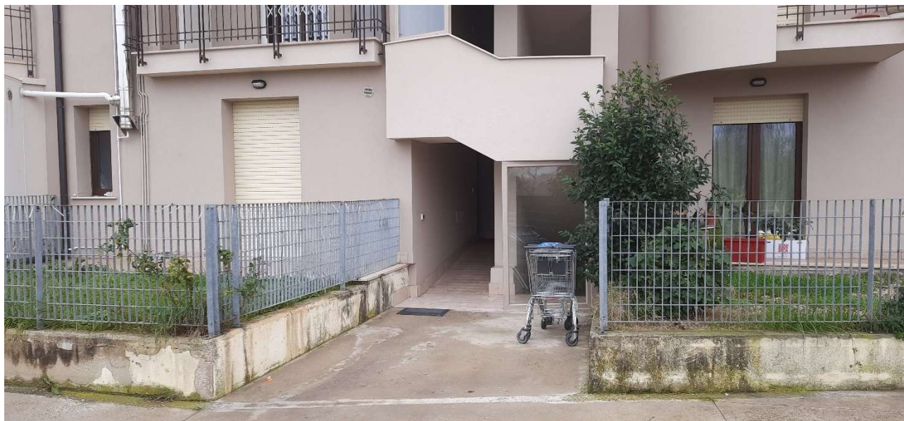
FOTO 5_VISTA ESTERNA- INGRESSO ALLA SCALA ESTERNA B DI RISALITA
