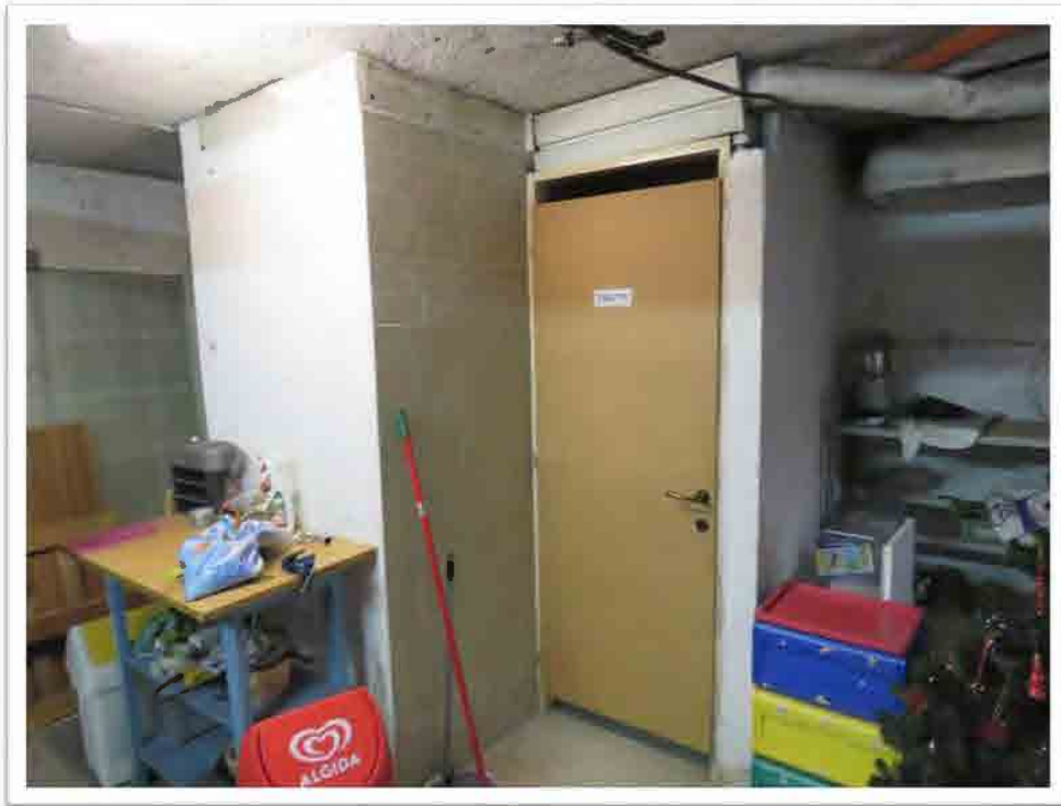
Il bagno ricavato nella cantina.
