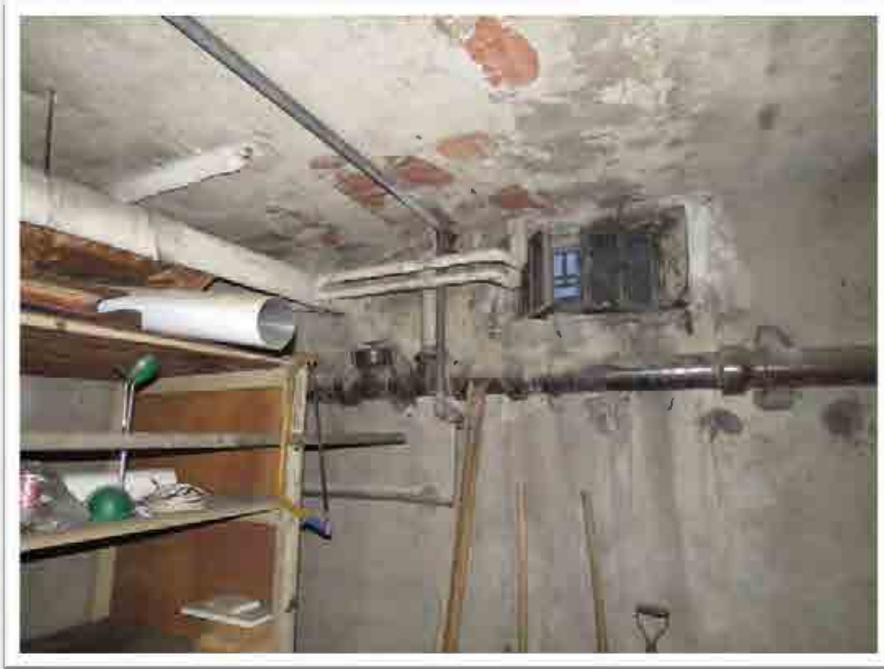
Altre viste del secondo vano di cantina.
