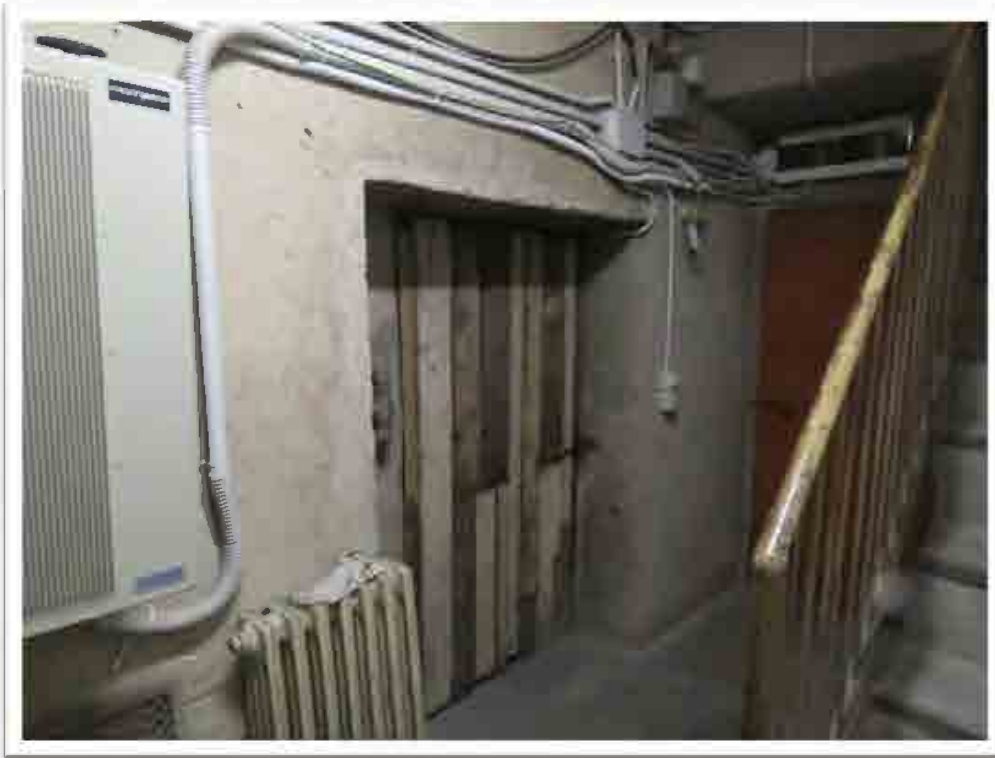
L'ingresso e vista interna del secondo vano di cantina.
