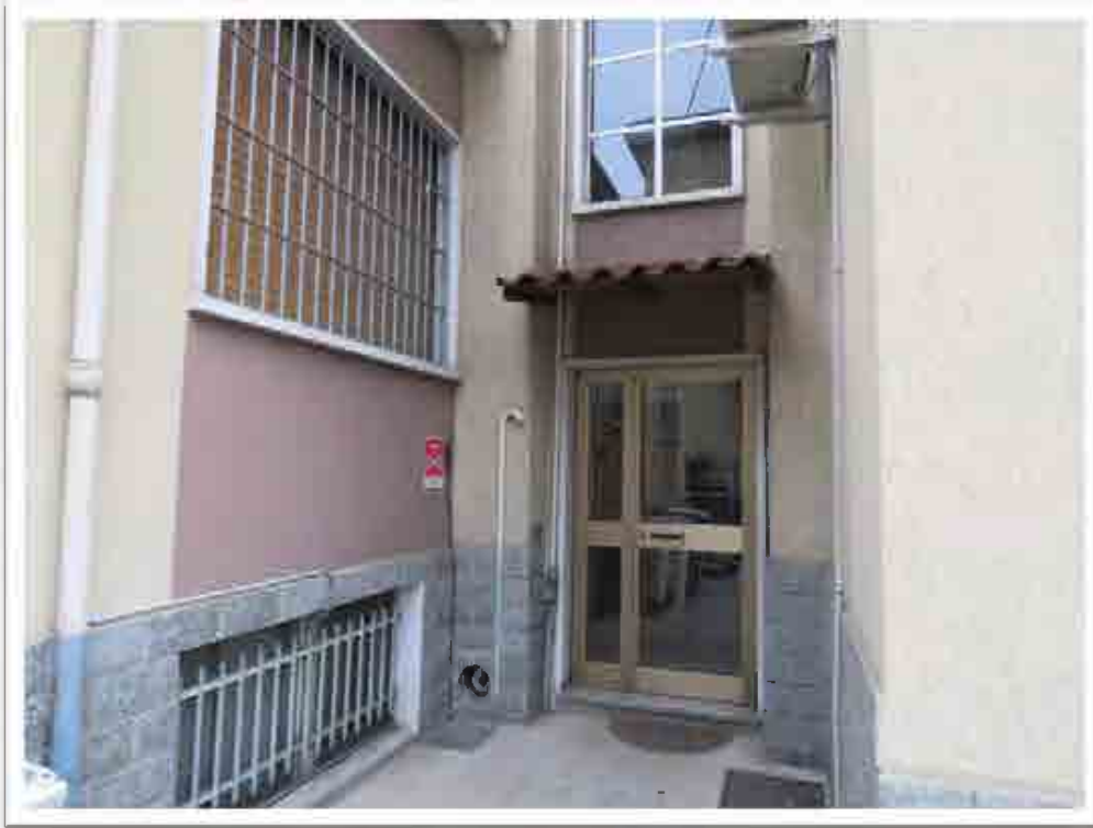
L'ingresso condominiale al secondo vano di cantina.
