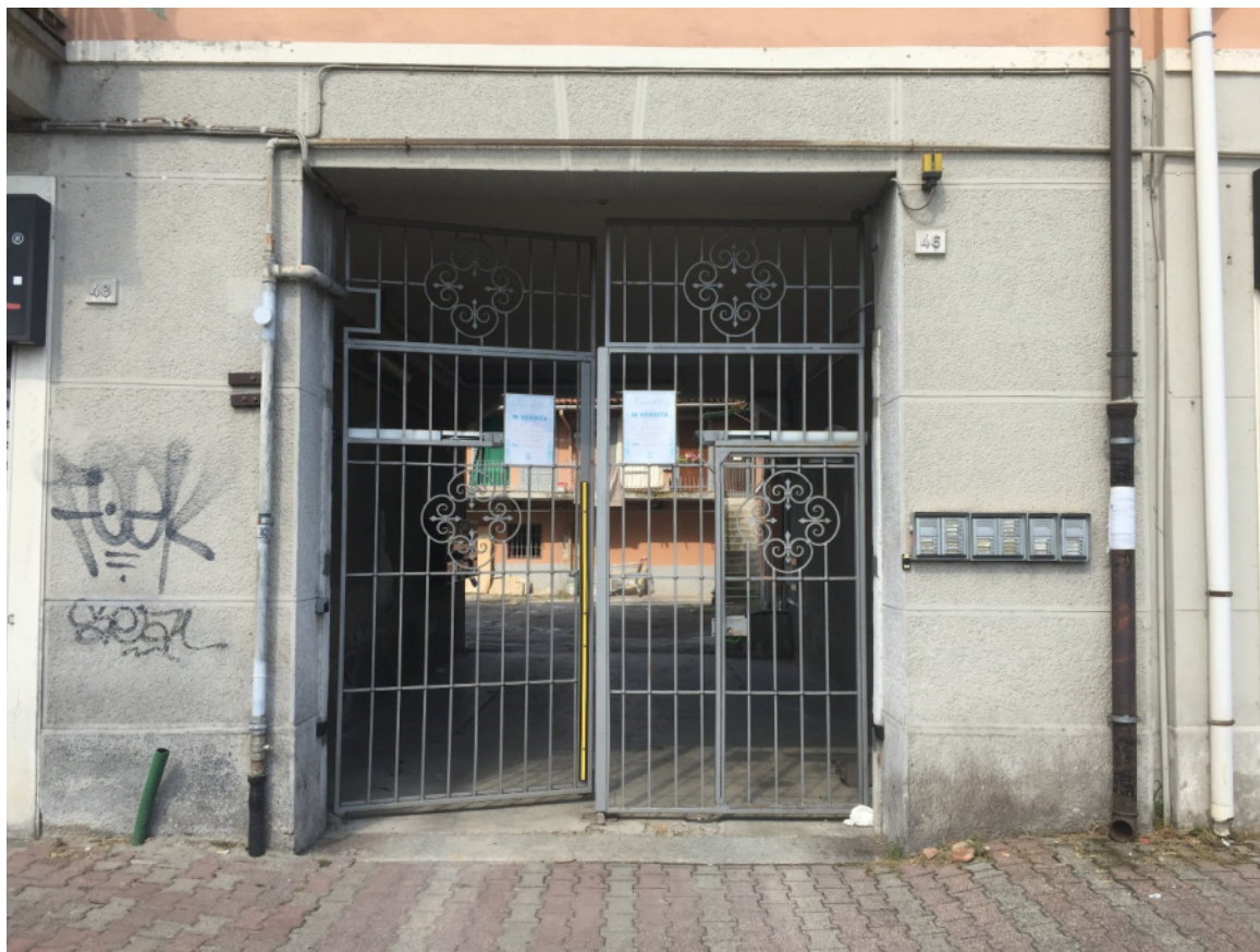
Foto 03 - Ingresso al fabbricato al civico 46 di via Emilia
