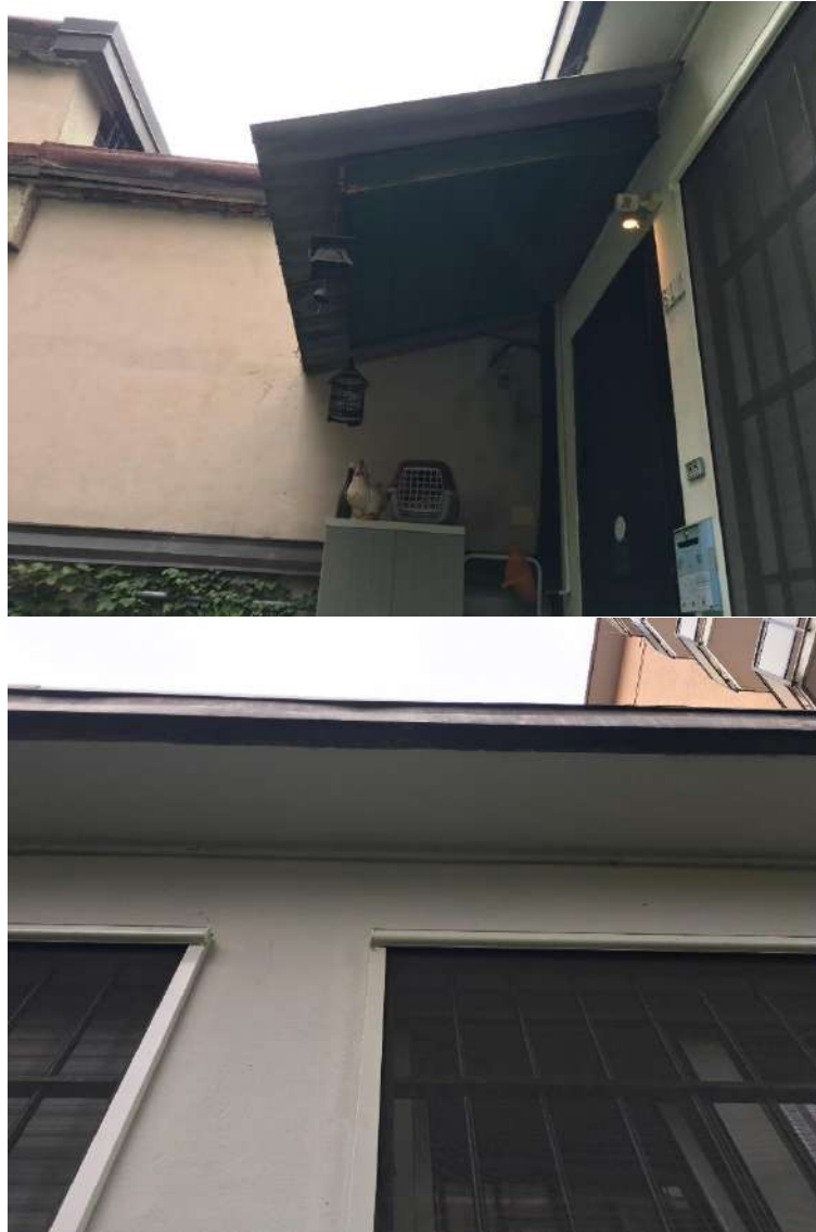
Figura 7 – ingresso al piano rialzato da scaletta esterna e particolare della gronda
