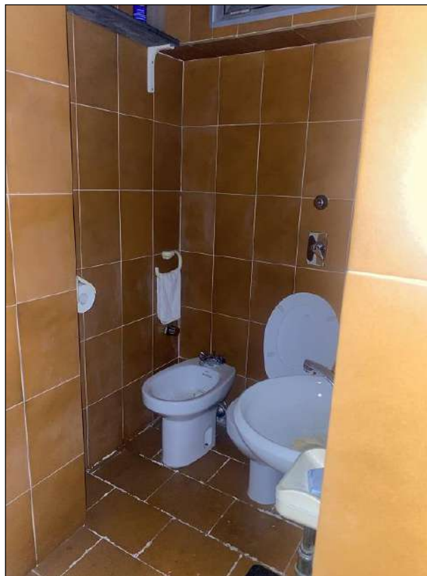
BAGNO – VISTA FOTOGRAFICA 25)
