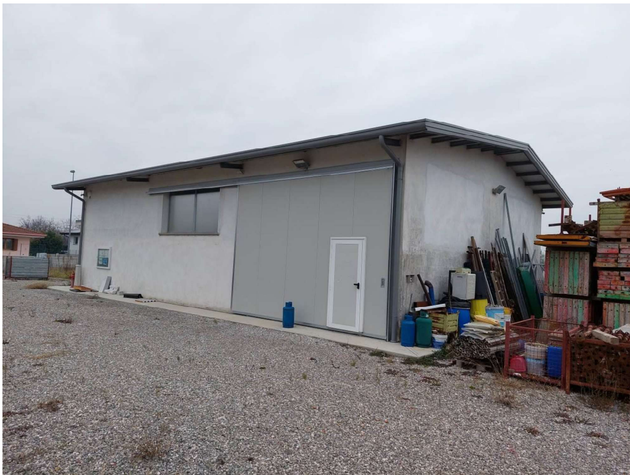
FOTO 3 - PROSPETTO LATERALE – ACCESSO MAGAZZINO
