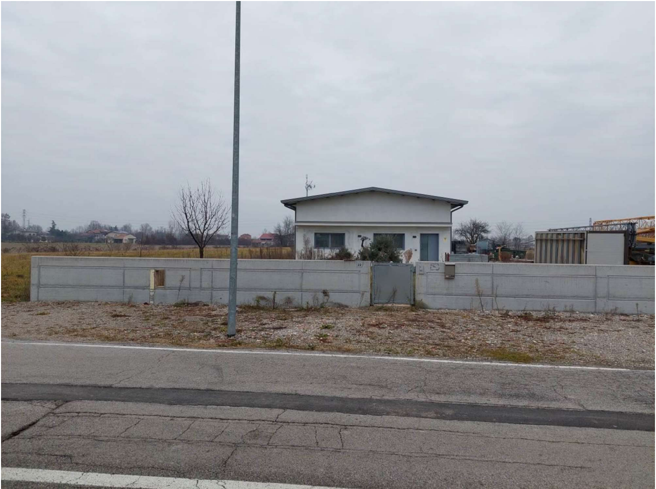
FOTO 6 – VISTA FRONTE STRADA – ACCESSO PEDONALE
