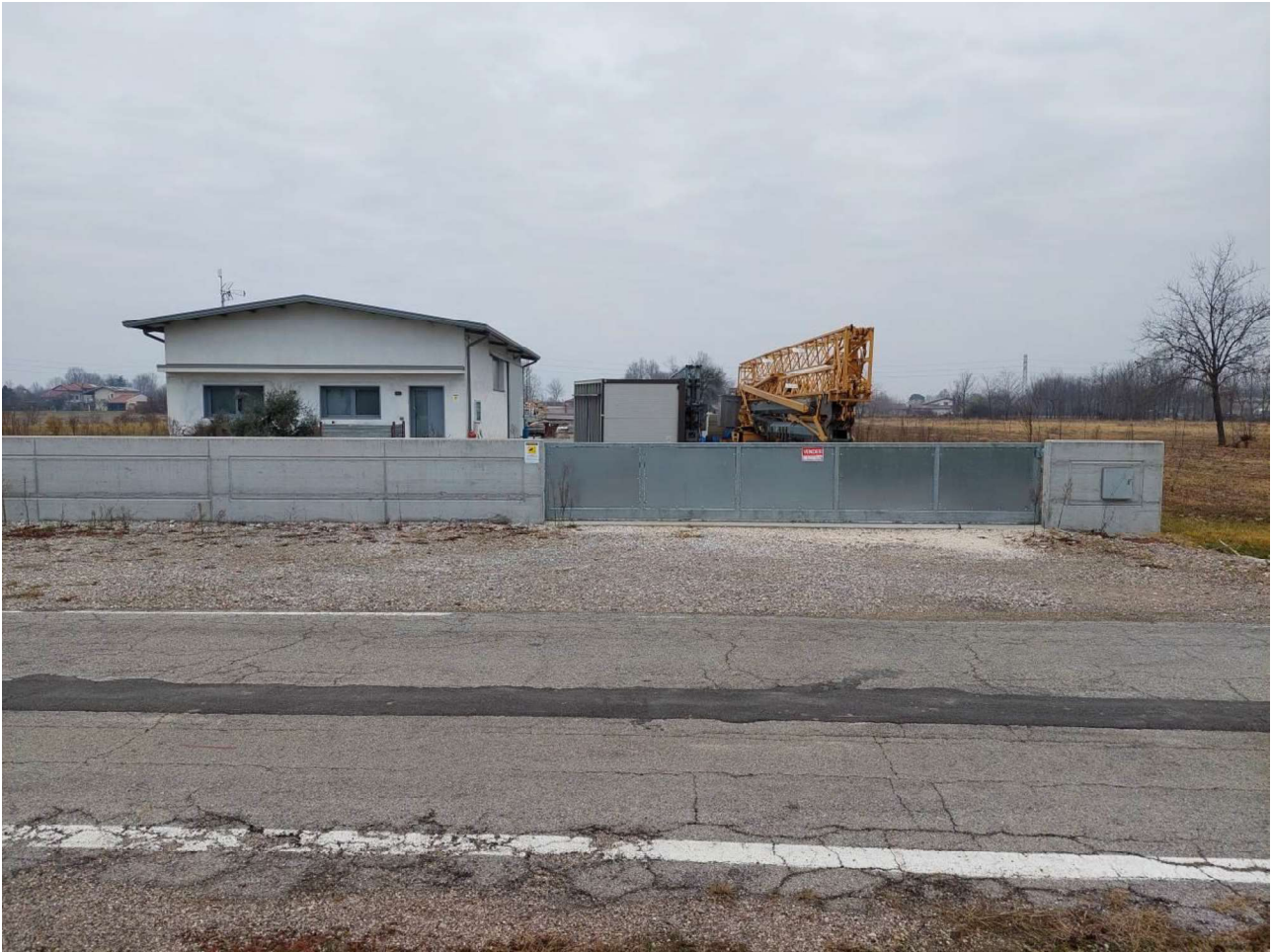
FOTO 5 – VISTA FRONTE STRADA – ACCESSO CARRAIO
