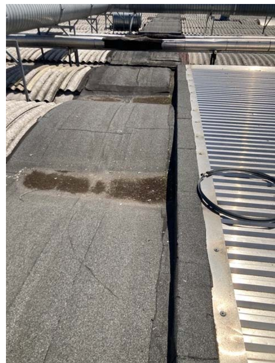
Foto della copertura
