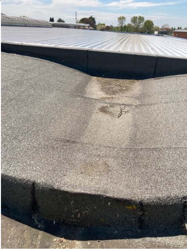
Foto della copertura
