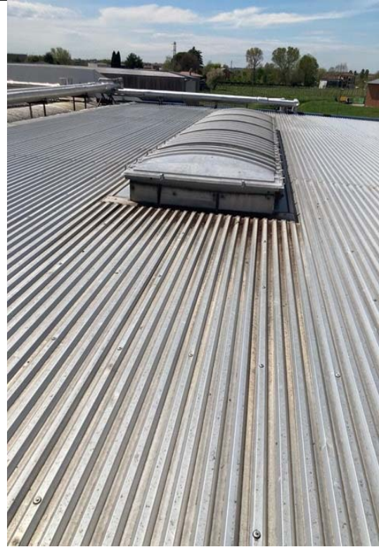
Foto della copertura
