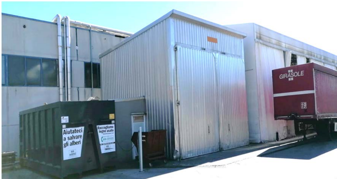
Esterno - Vista manufatto uso essiccatoio
