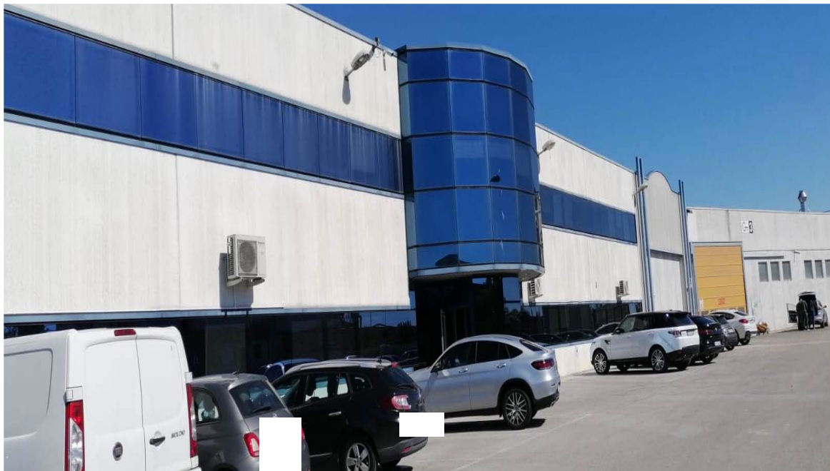
Esterno - Vista prospetto fronte ingresso
