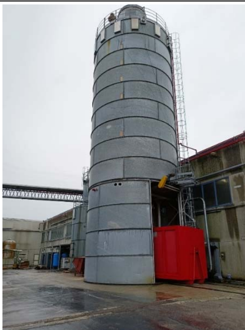
Silos in struttura metallica
