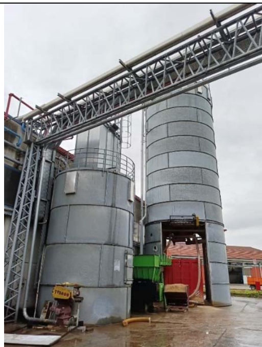
Silos in struttura metallica
