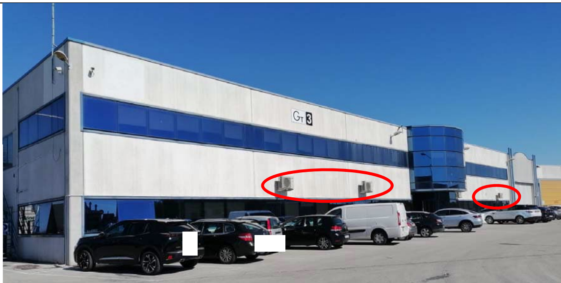
Esterno – Vista prospetto principale
