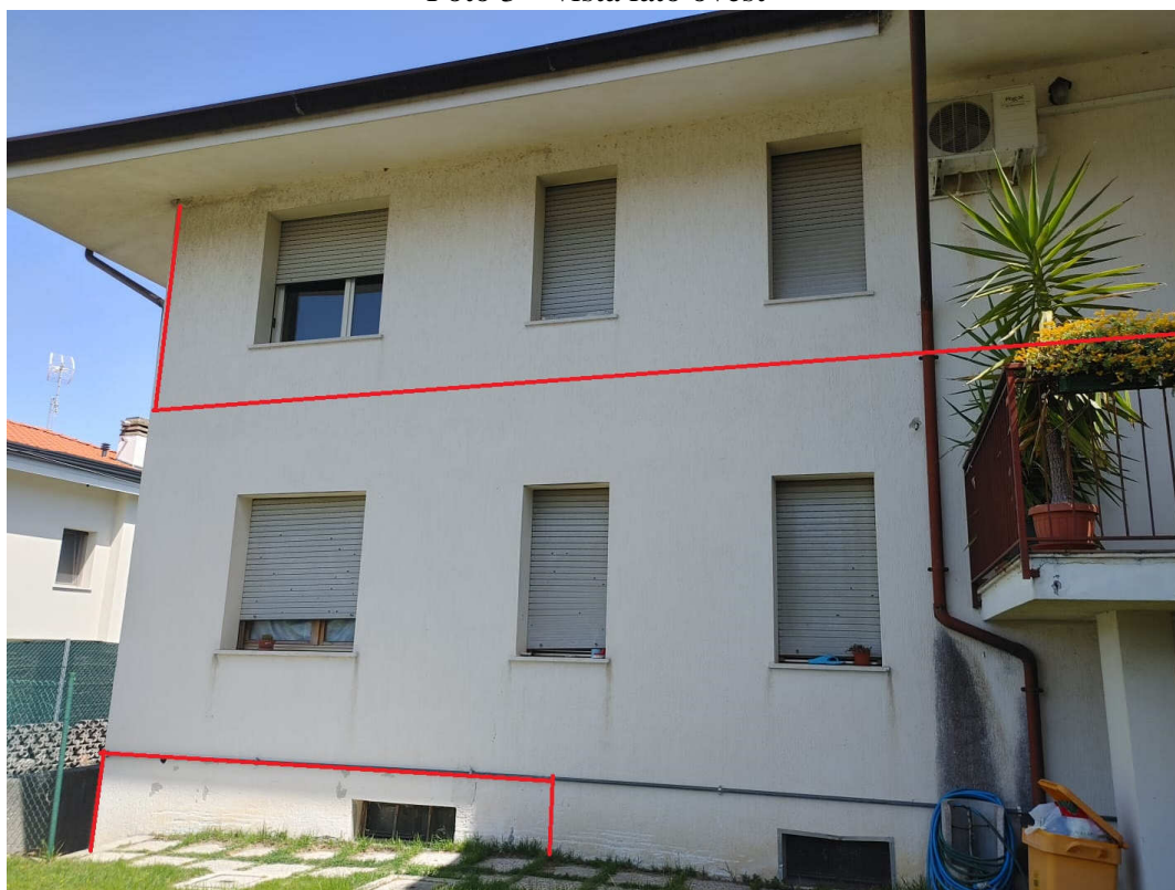
Foto 3 – vista lato ovest
