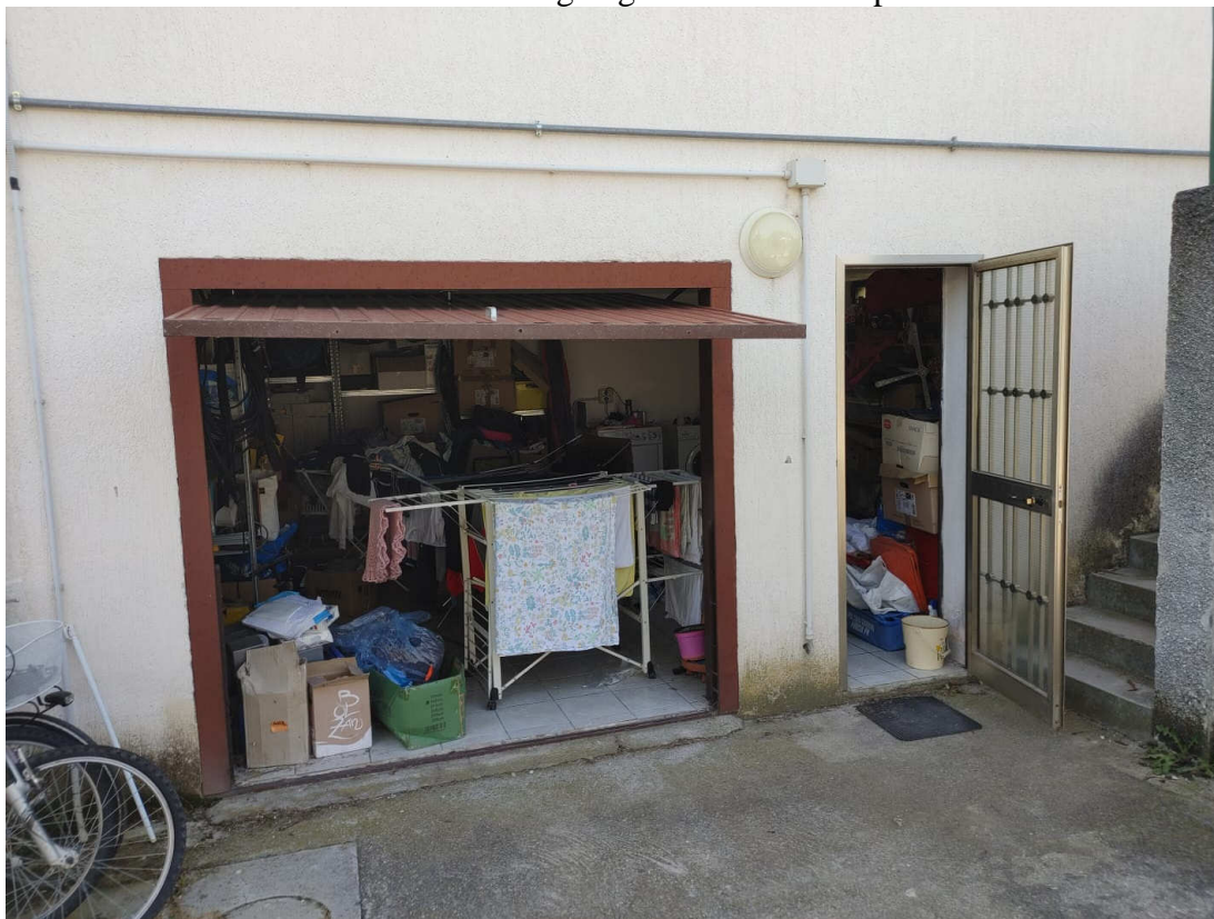
Foto 17 – vista entrata garage e ex cantina al piano S1
