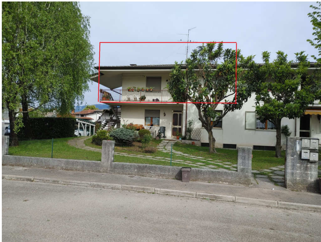
Foto 1 – vista da Via del Parco
