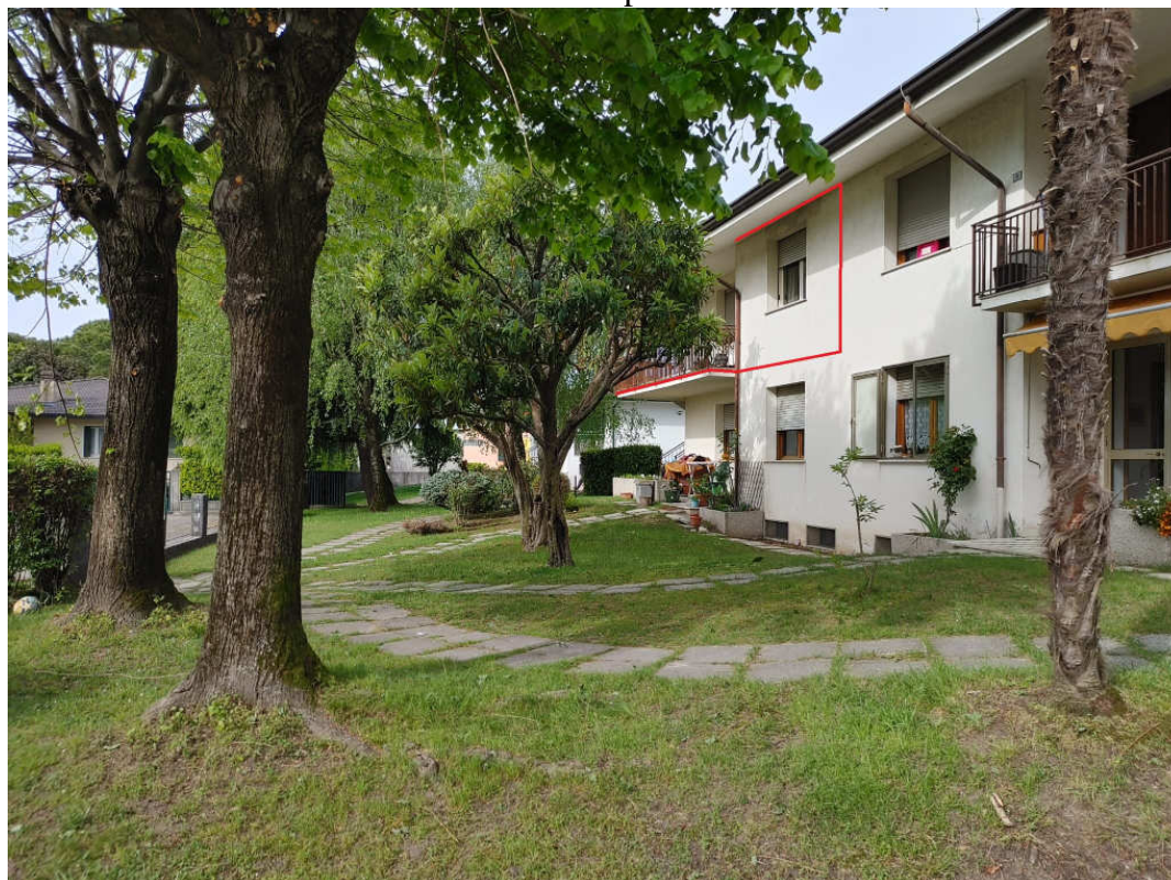
Foto 4 – vista scoperto lato sud
