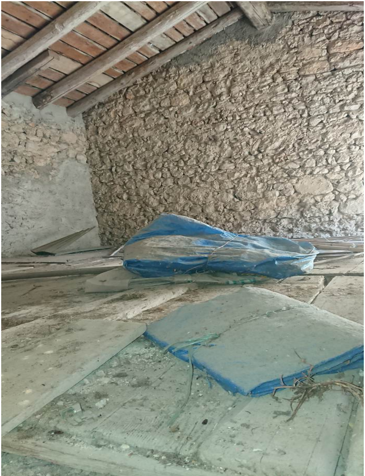
Foto n° 27 - 18/01/2022 - Comune di Caneva, foglio 21, part.159 – Piano primo.
