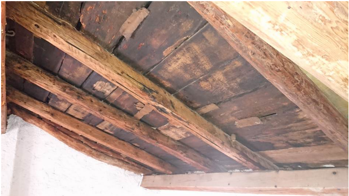
Foto n° 21 - 18/01/2022 - Comune di Caneva, foglio 21, part.156-157 – Particolare del tetto di copertura.
