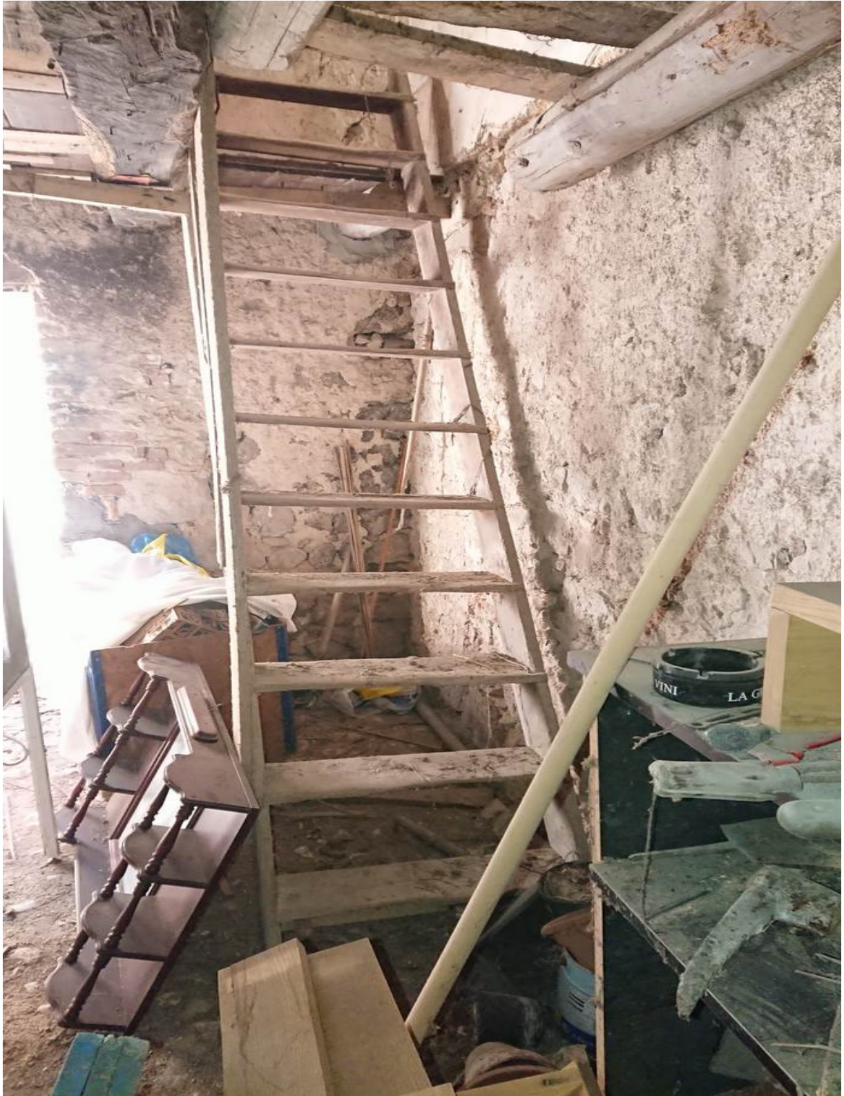
Foto n° 26 - 18/01/2022 - Comune di Caneva, foglio 21, part.159 – Scala di accesso al piano primo.
