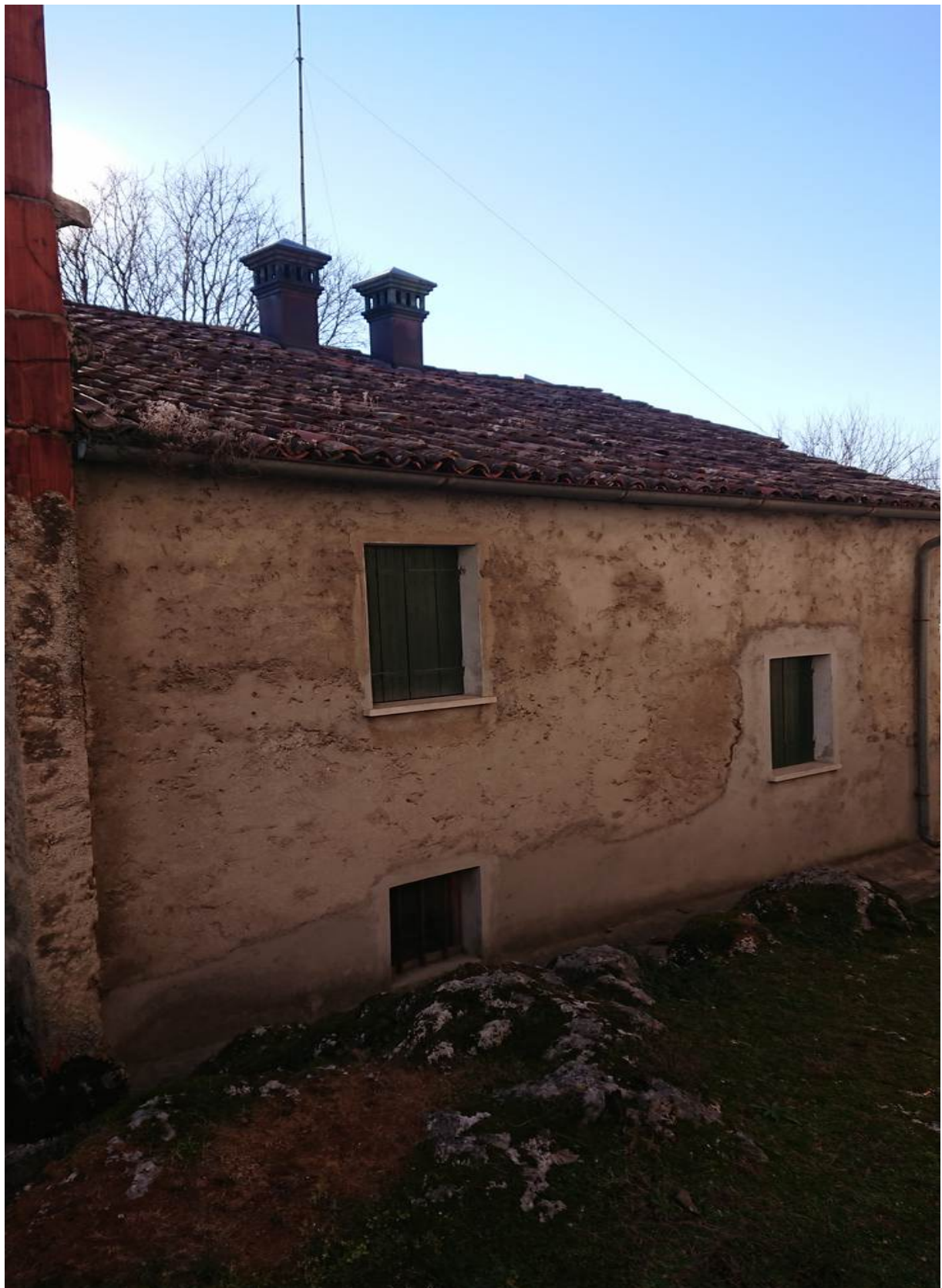
Foto n° 23 - 18/01/2022 - Comune di Caneva, foglio 21, part.156-157 – Esterno dell'abitazione, parete nord.
