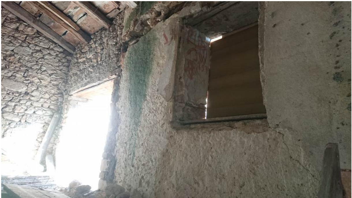
Foto n° 28 - 18/01/2022 - Comune di Caneva, foglio 21, part.159 – Piano primo.
