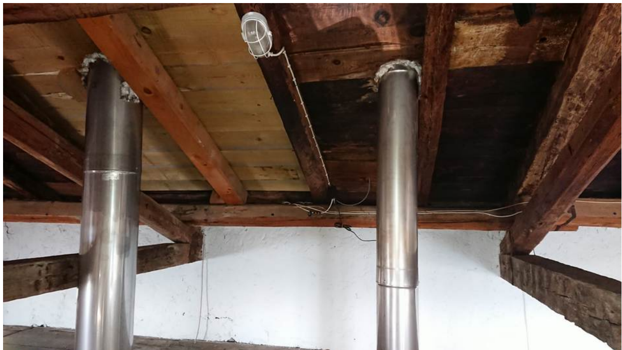
Foto n° 20 - 18/01/2022 - Comune di Caneva, foglio 21, part.156-157 – Sottotetto.
