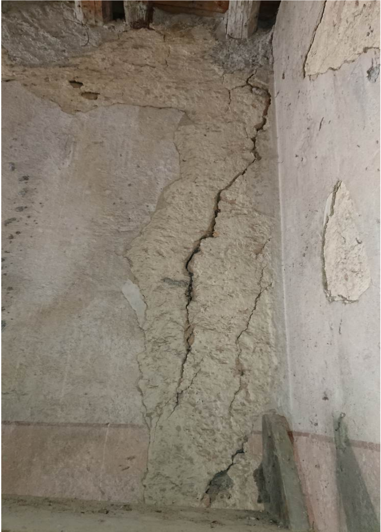
Foto n° 29 - 18/01/2022 - Comune di Caneva, foglio 21, part.159 – Particolare dei muri.
