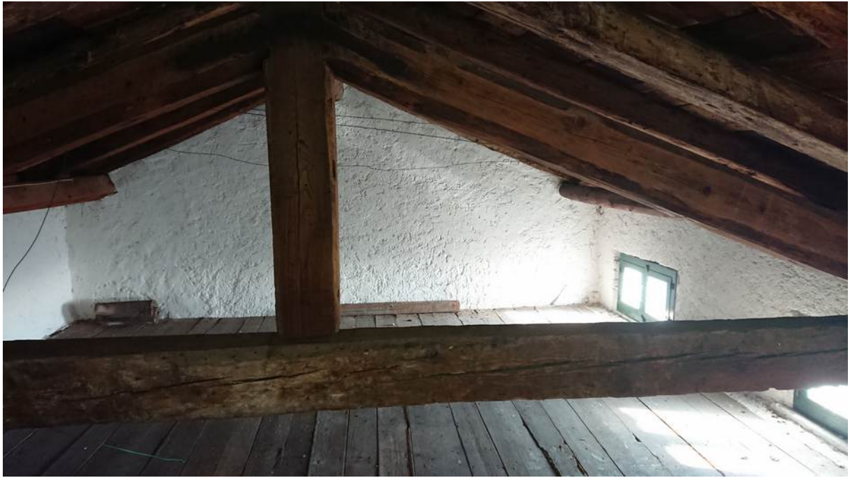
Foto n° 19 - 18/01/2022 - Comune di Caneva, foglio 21, part.156-157 – Sottotetto.
