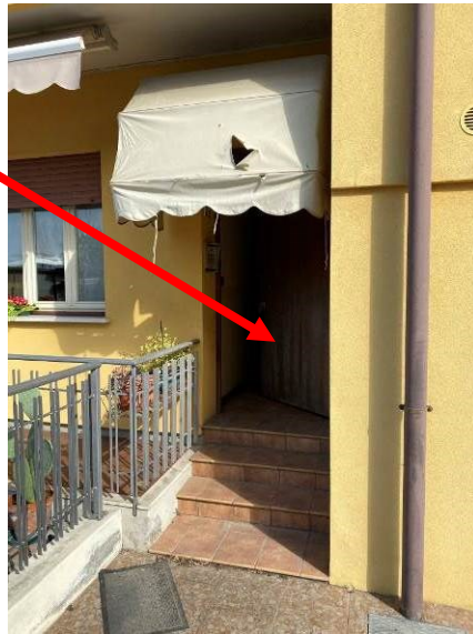
vista ingresso al piano terra
