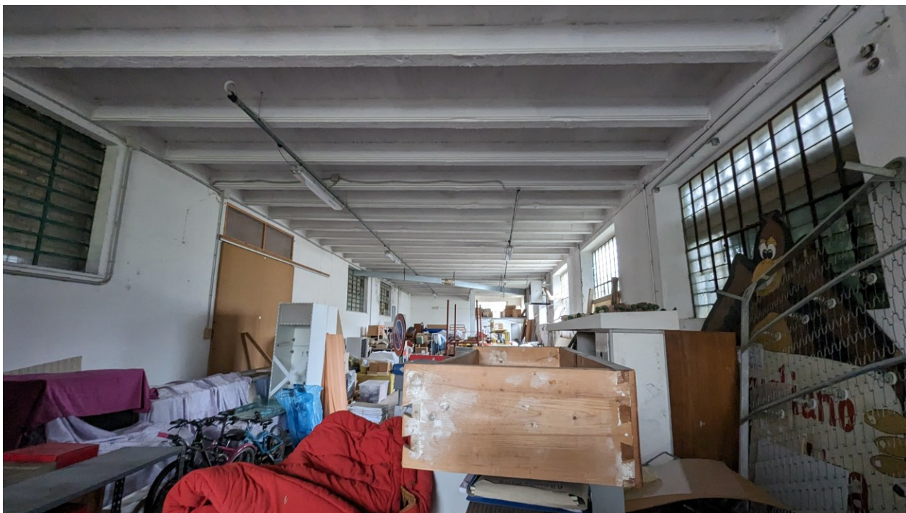
10 Vista interna del Laboratorio Lotto 5 sub. 2
