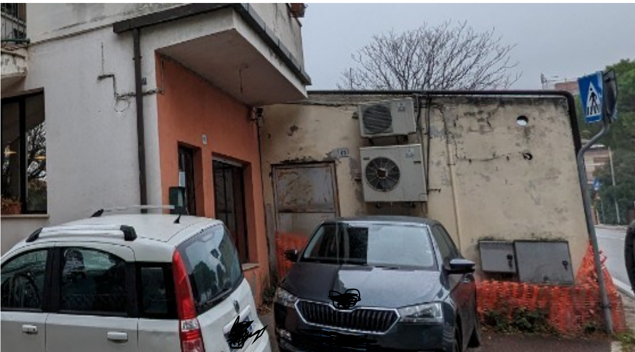
12 Vista dell'accesso lato ovest al Lotto 6 sub. 6 Laboratorio collabente
