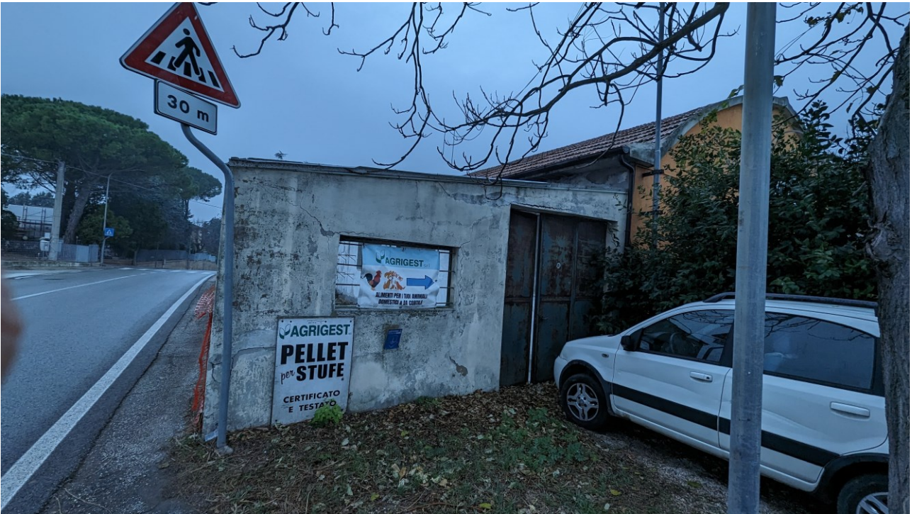
12 Vista dell'accesso lato est al Lotto 6 sub. 6 Laboratorio collabente
