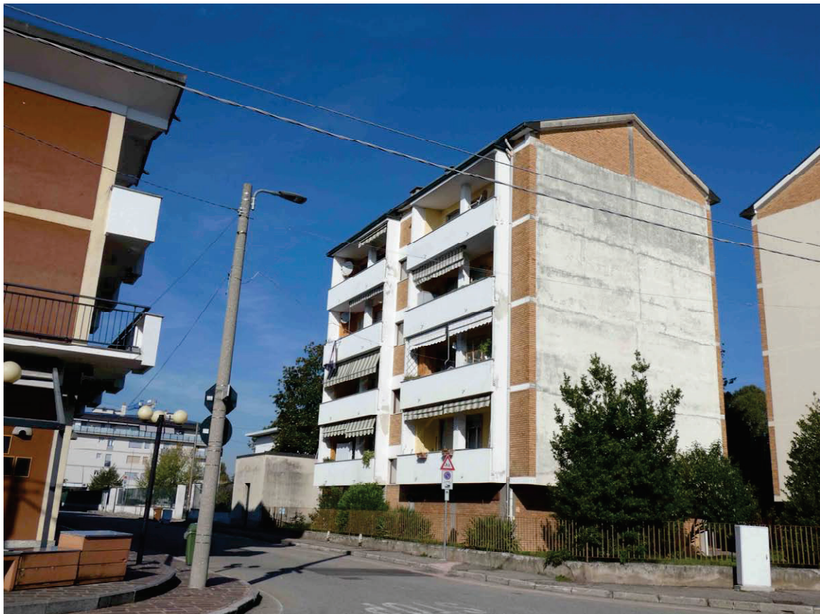
Foto 4. Prospetto su Via Petrarca
