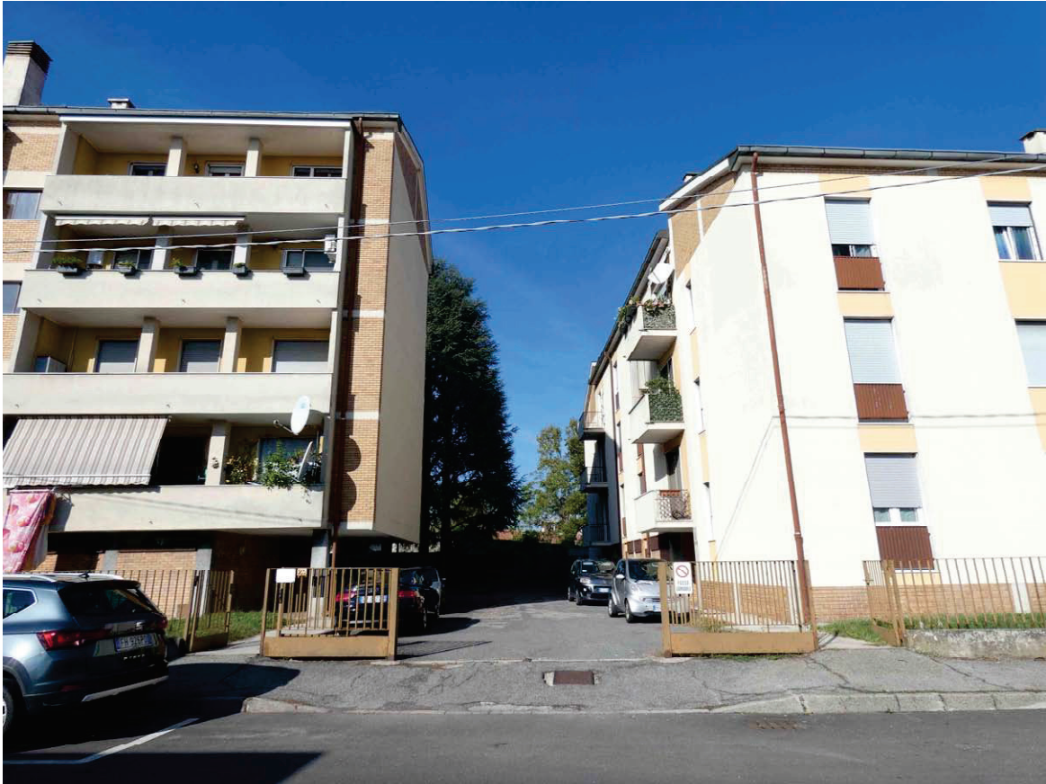
Foto 1. Accesso pedonale e carroia al civico 23 di Via Trento
