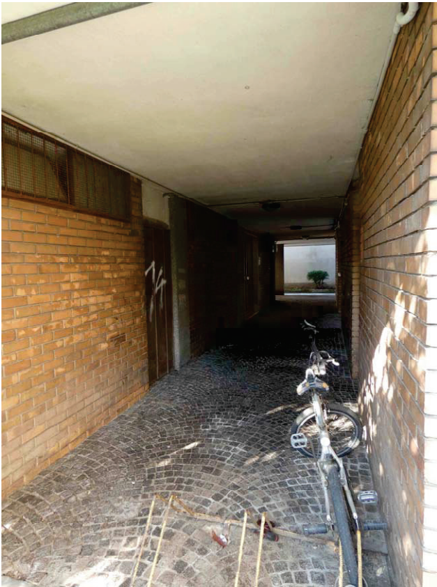
Foto 5. Porticato al piano terra
