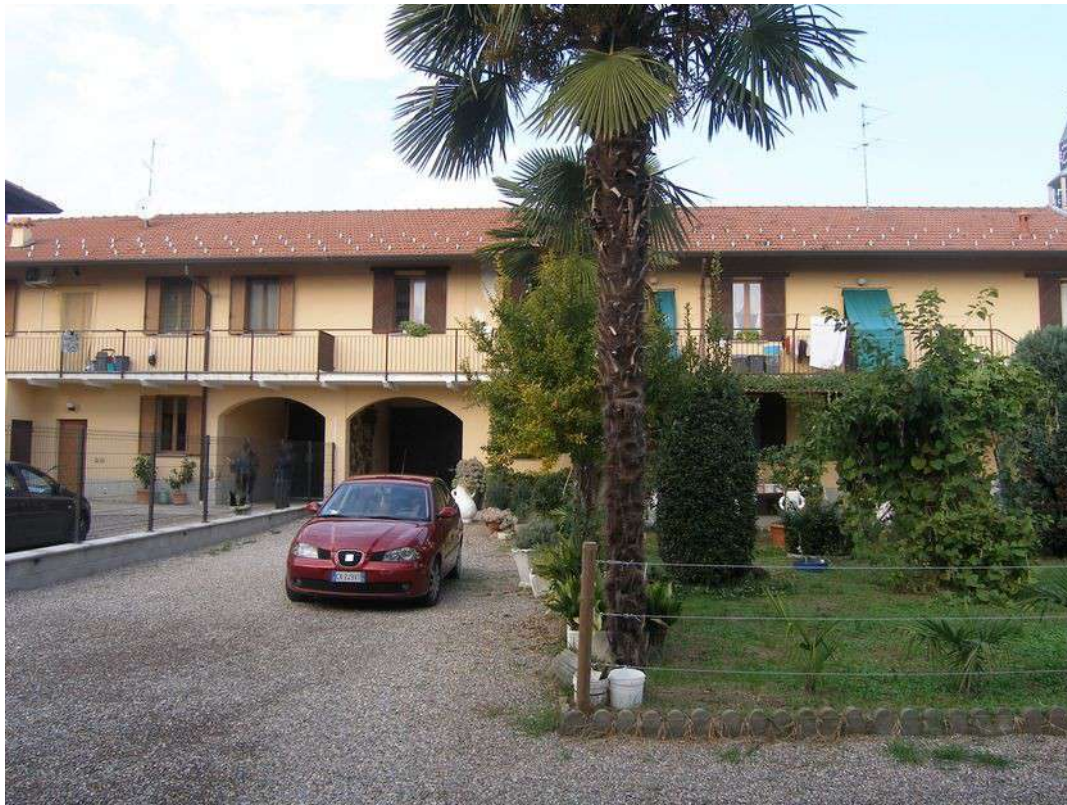
Vista corpo di fabbrica su strada
