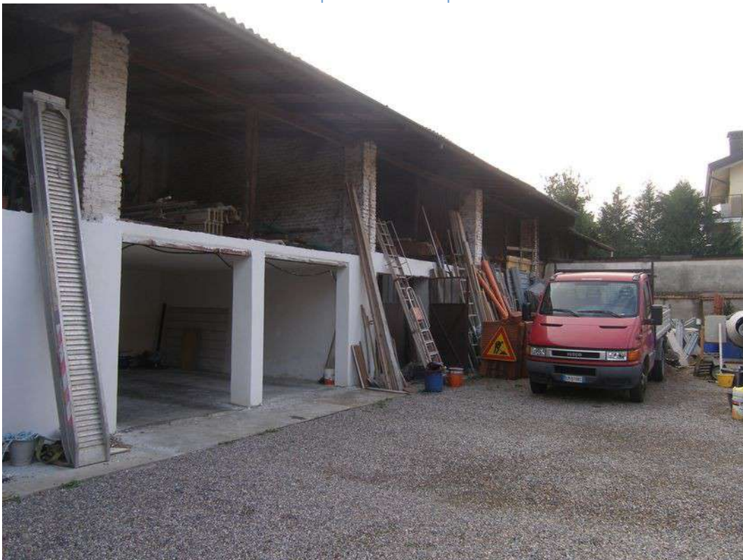
Vista corpo di fabbrica deposito
