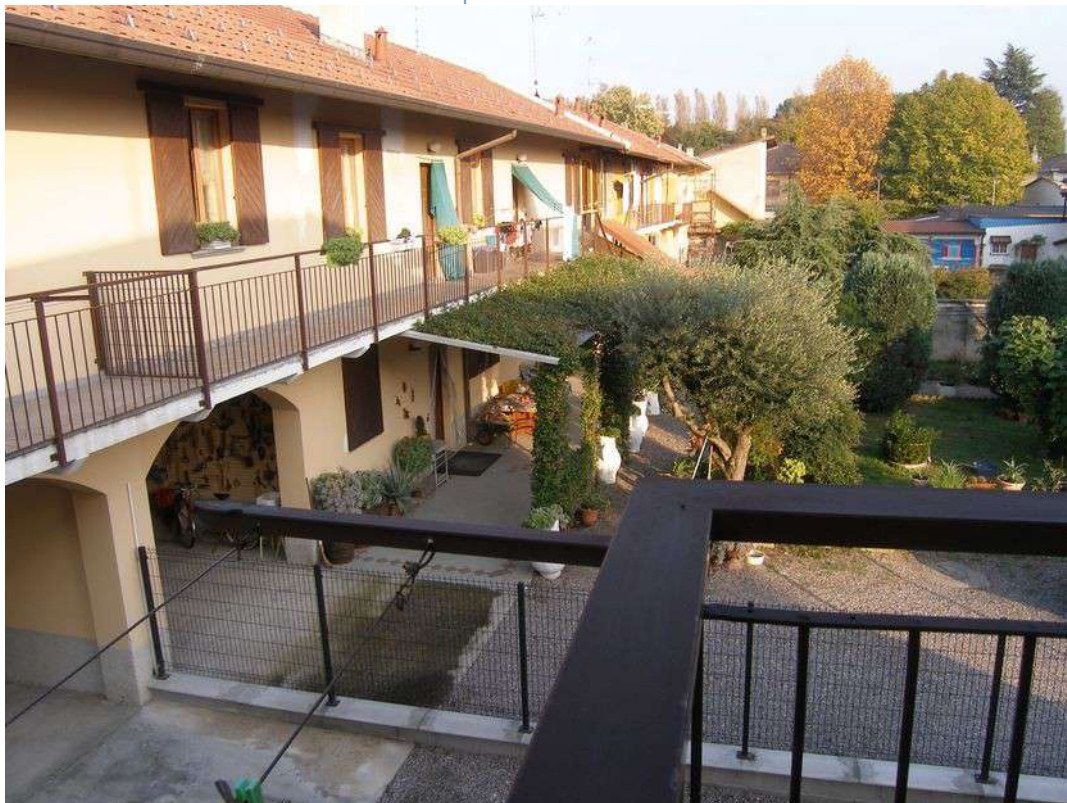
Vista corpo di fabbrica su strada
