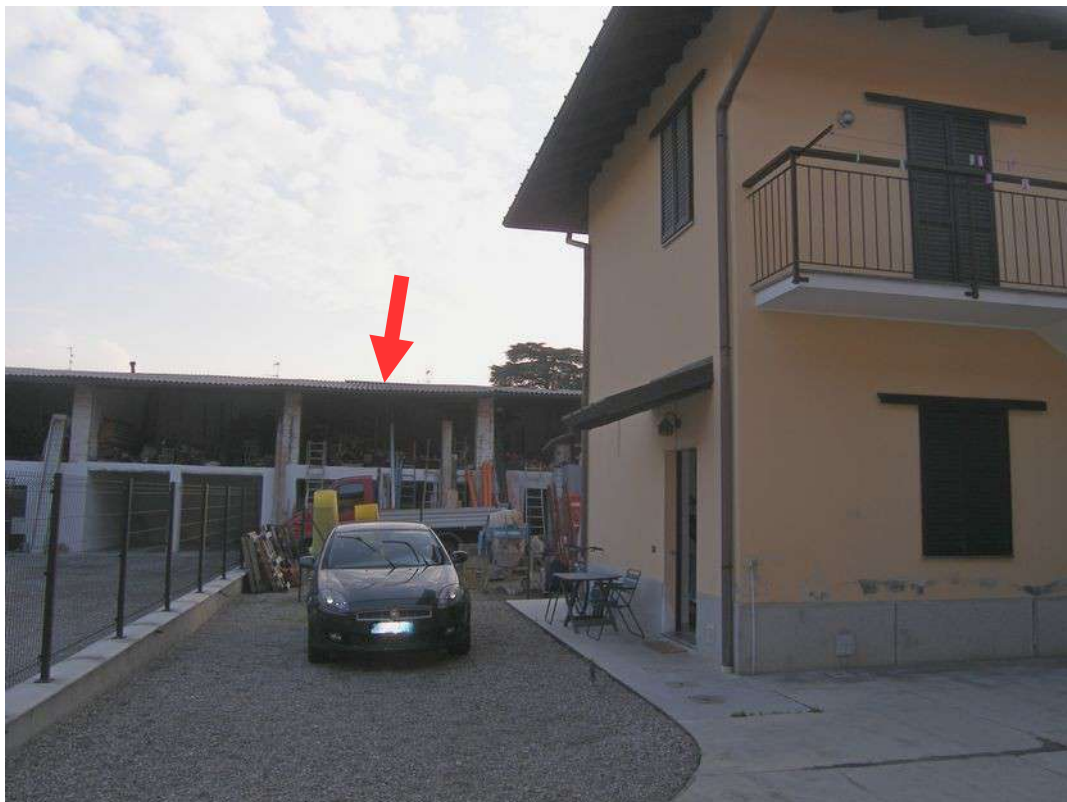
Vista corpi di fabbrica appartamento e deposito
