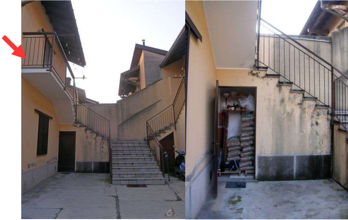
Vista scala da cortile comune
