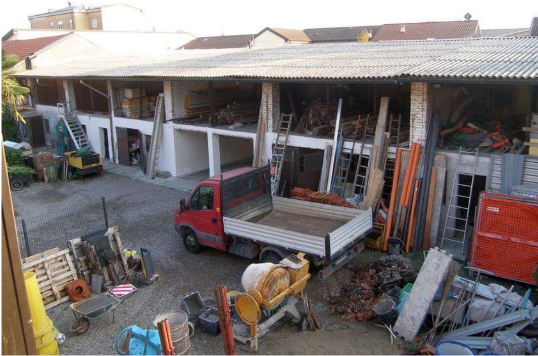
Vista corpo di fabbrica deposito
