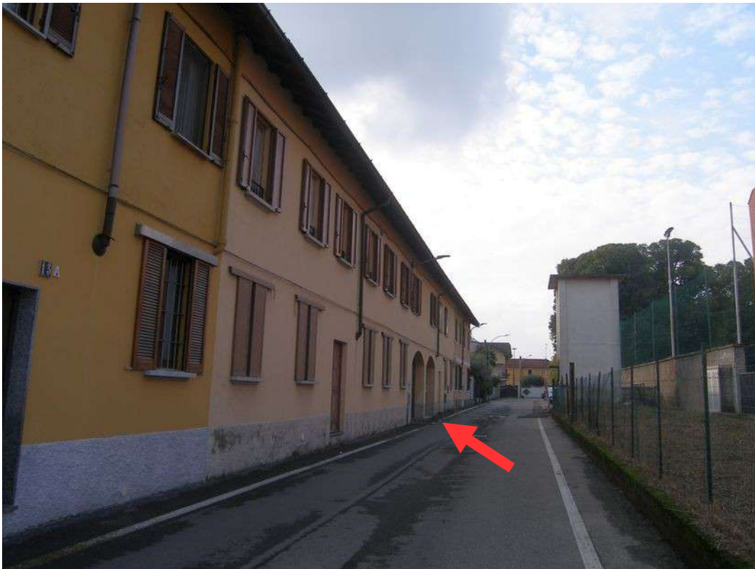
Vista immobile fronte su strada
