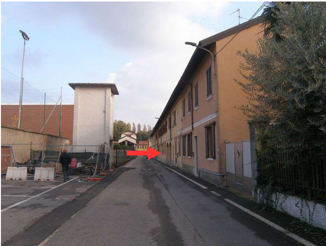
Vista immobile fronte su strada
