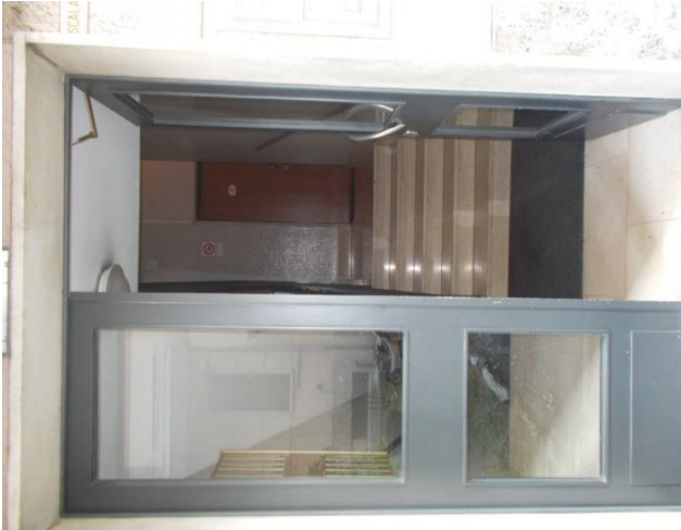
VISTE ESTERNE E SCALE DI ACCESSO AL PIANO
