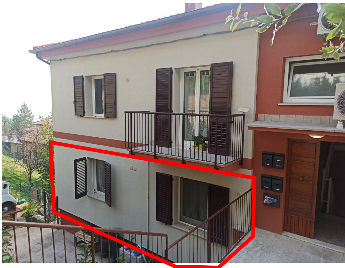
foto 02 – veduta del fabbricato da viale Risorgimento, con evidenziazione dell'appartamento
