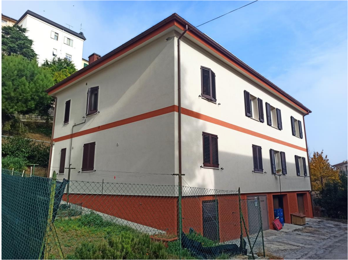
foto 03 – veduta generale del fabbricato da Sud Ovest
