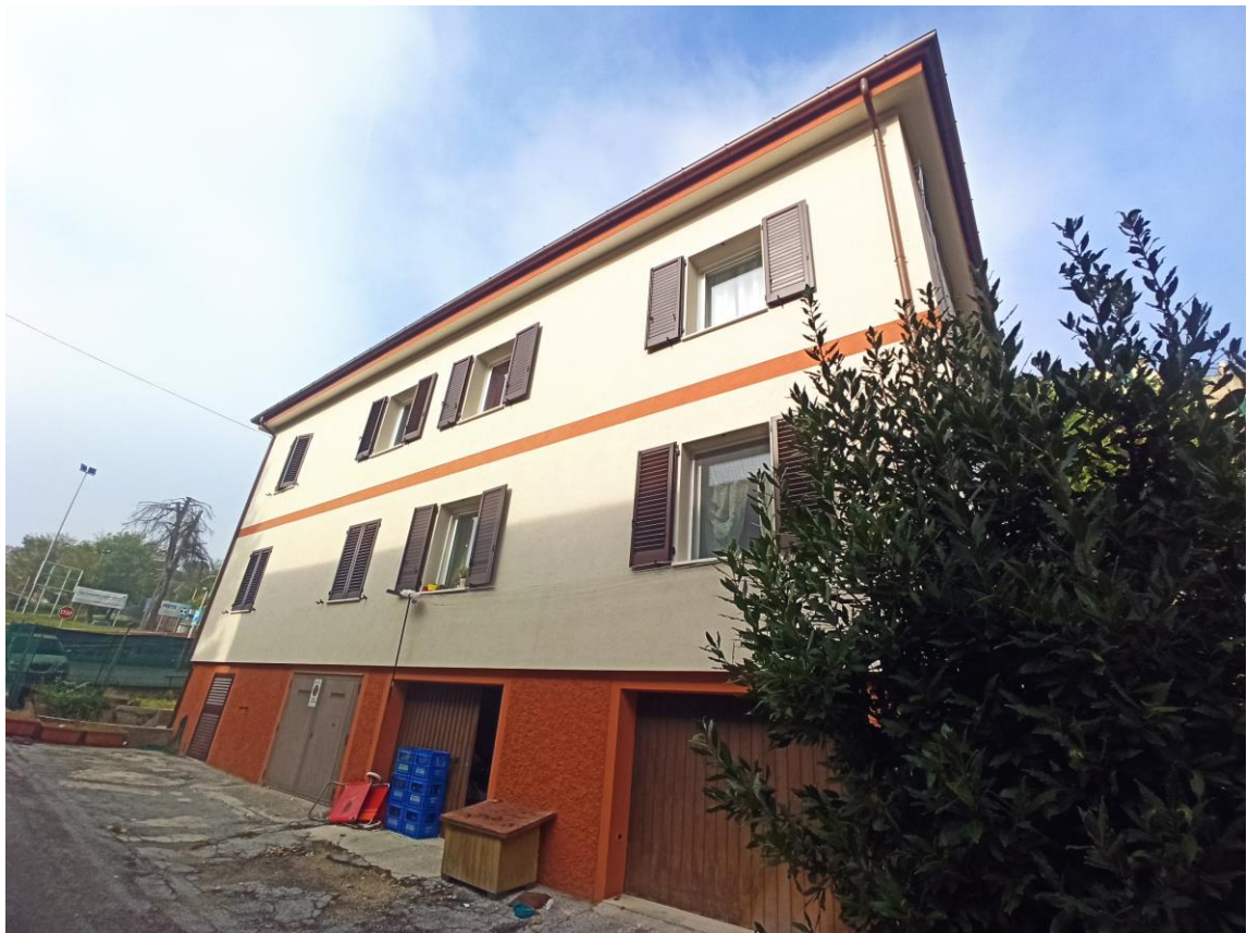
foto 04 – veduta generale del fabbricato da Sud Est
