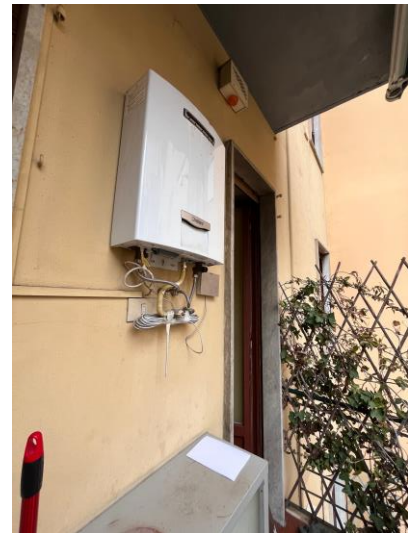
Immagini 12 e 13. Il balcone; si nota lo scaldabagno a gas per la produzione di acqua calda sanitaria.
