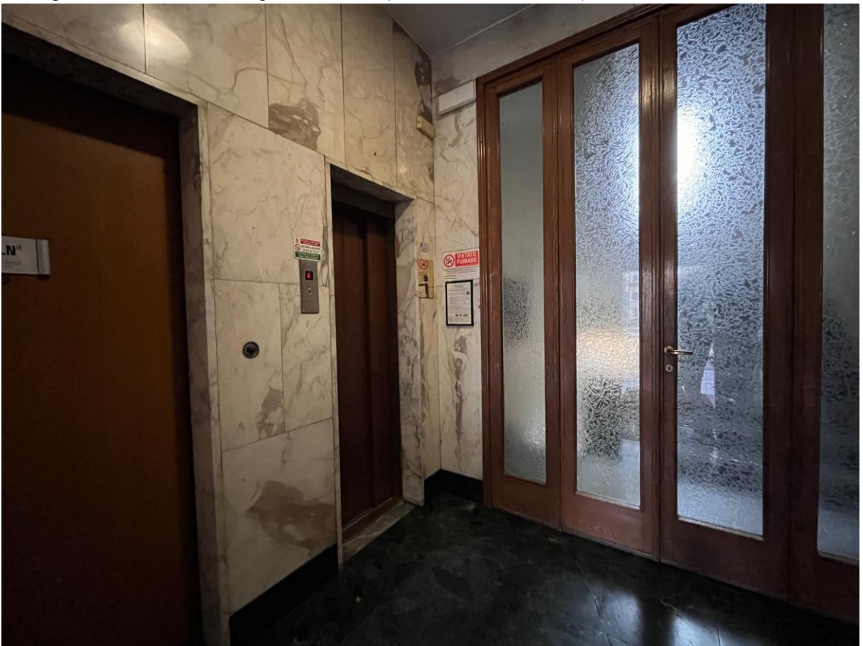
Immagine 6. L'androne con l'ascensore che parte dalla quota del piano rialzato.
