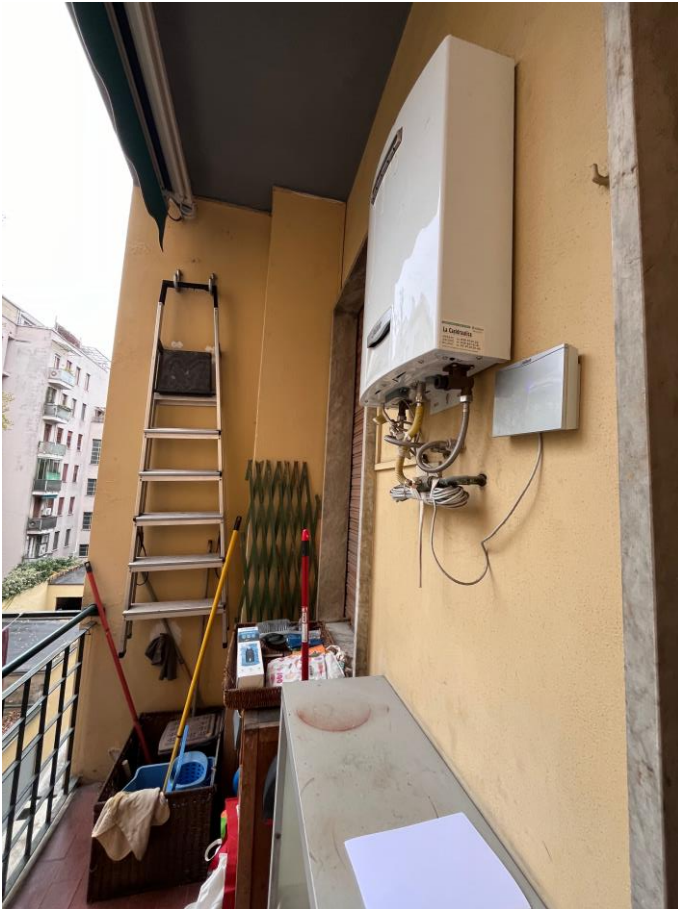
Immagini 12 e 13. Il balcone; si nota lo scaldabagno a gas per la produzione di acqua calda sanitaria.
