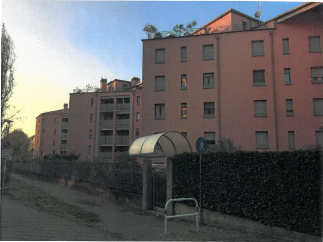
Foto 03 - Il fabbricato sul retro
