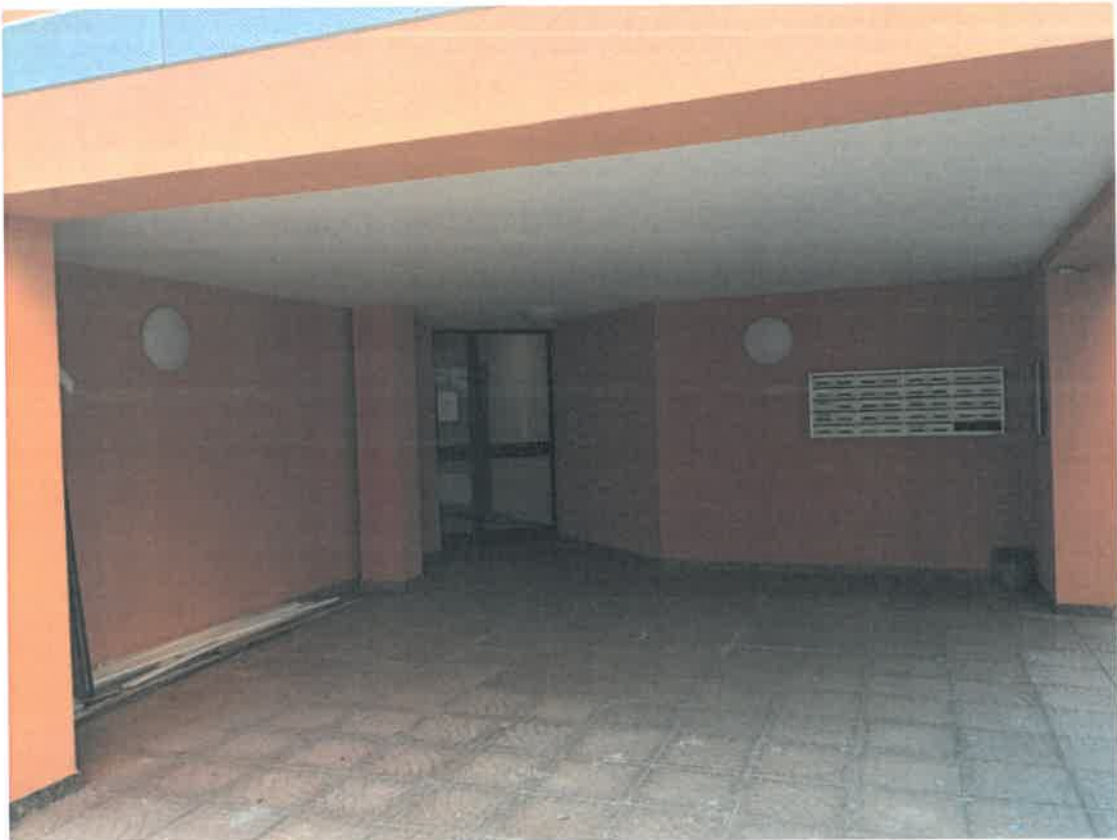
Foto 06 - Accesso alla scala A del fabbricato
