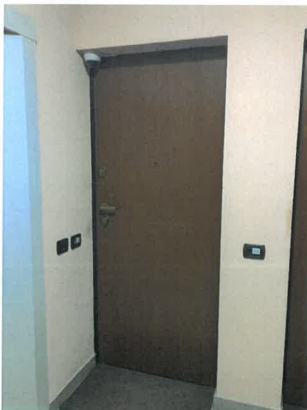
Foto 07 - Ingresso all'unità dal pianerottolo
