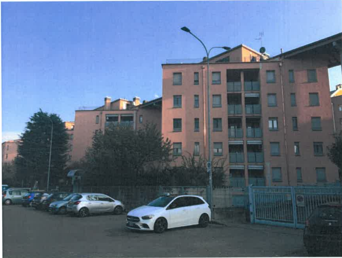
Foto 01 - Il fabbricato su via Gianni Riccardi
