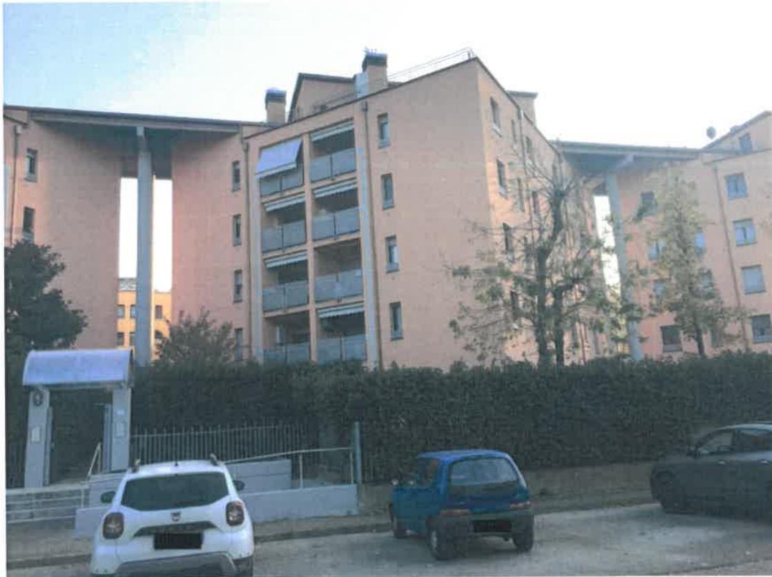
Foto 02 - Il fabbricato su via Gianni Riccardi
