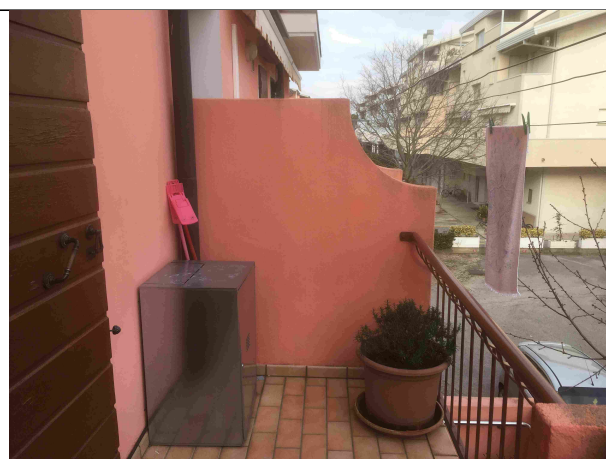
Veduta terrazzo p. 1 - Sub. 15
