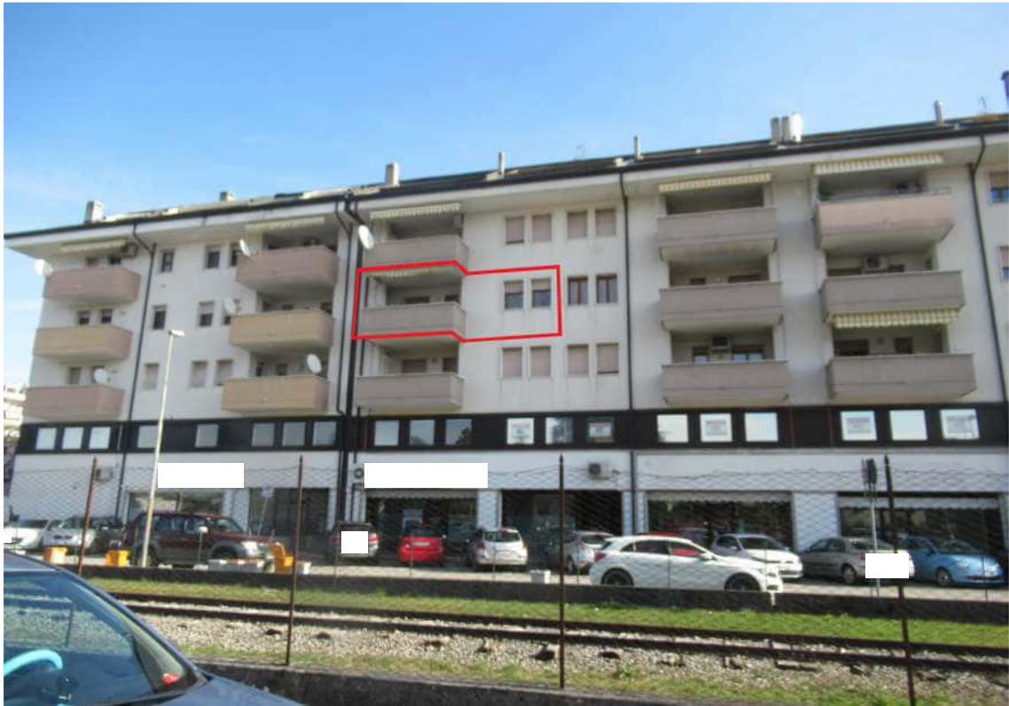
Foto 1: Vista alloggio prospettante Ovest
