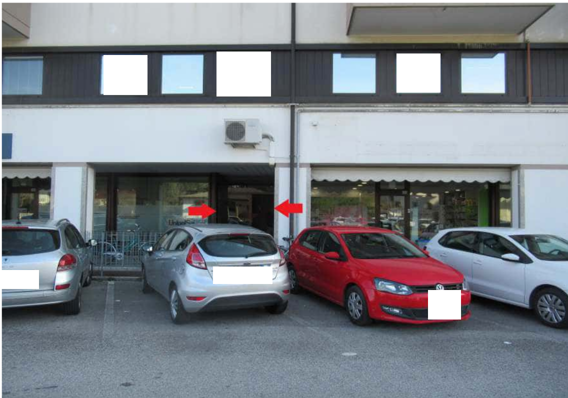
Foto 2: Ingresso condominiale scala C
