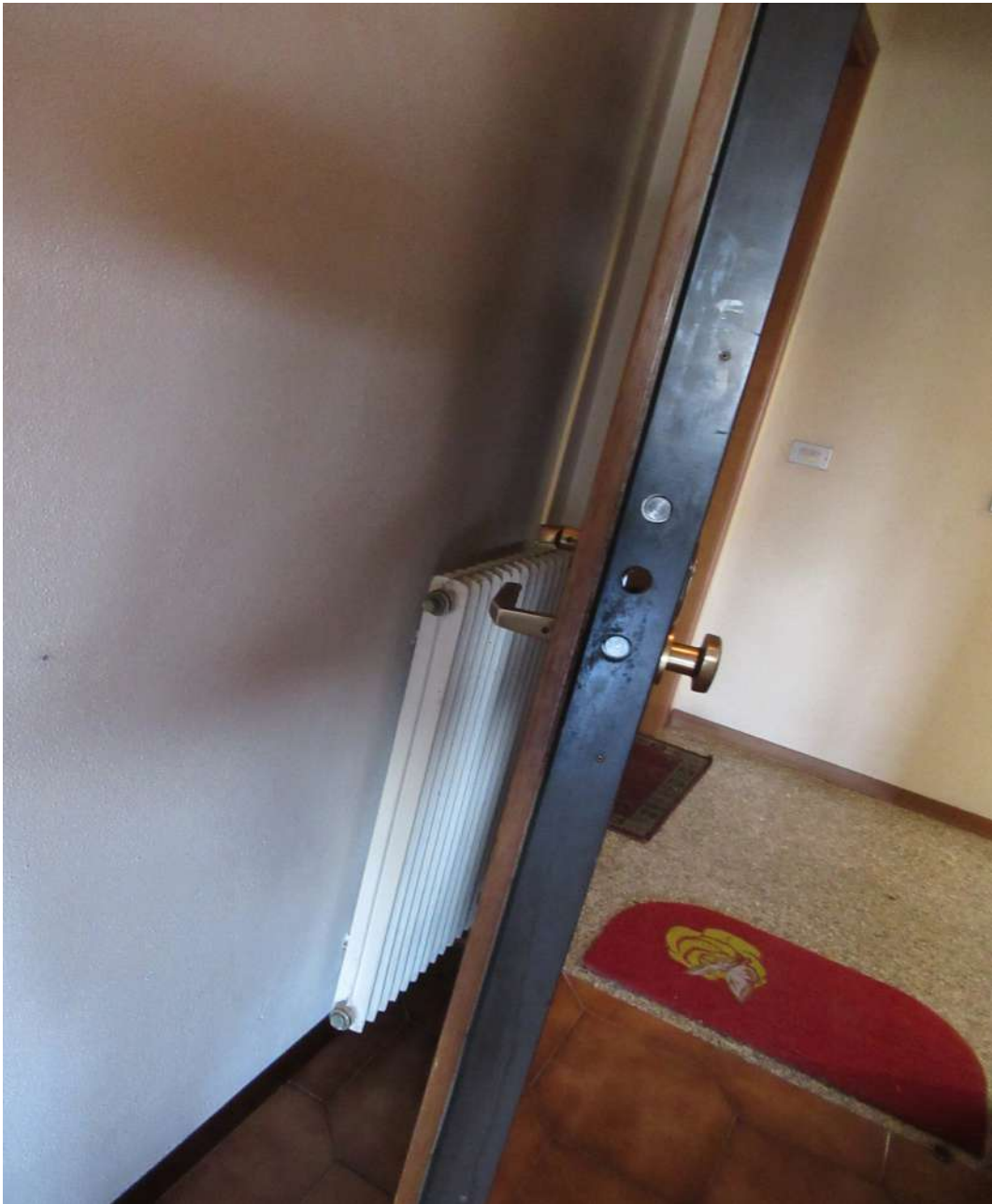
Foto 4: Particolare portoncino blindato
