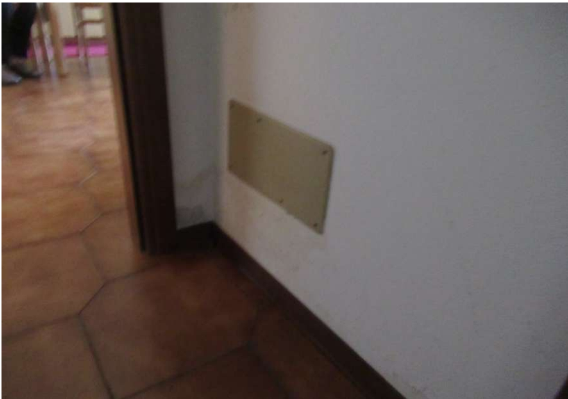
Foto 10: Infiltrazione riparata bagno disimpegno notte
