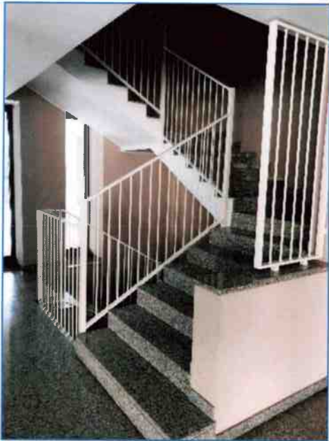
Foto 11 - vano scala comune
