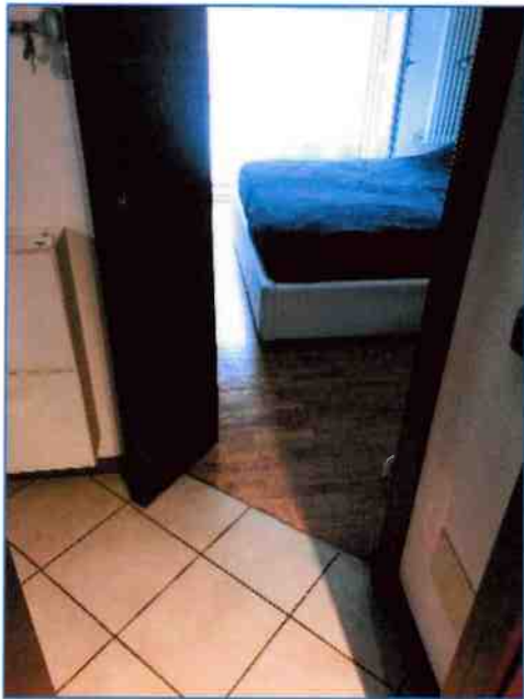
Foto 17 - dettaglio pavimento disimp./camera
