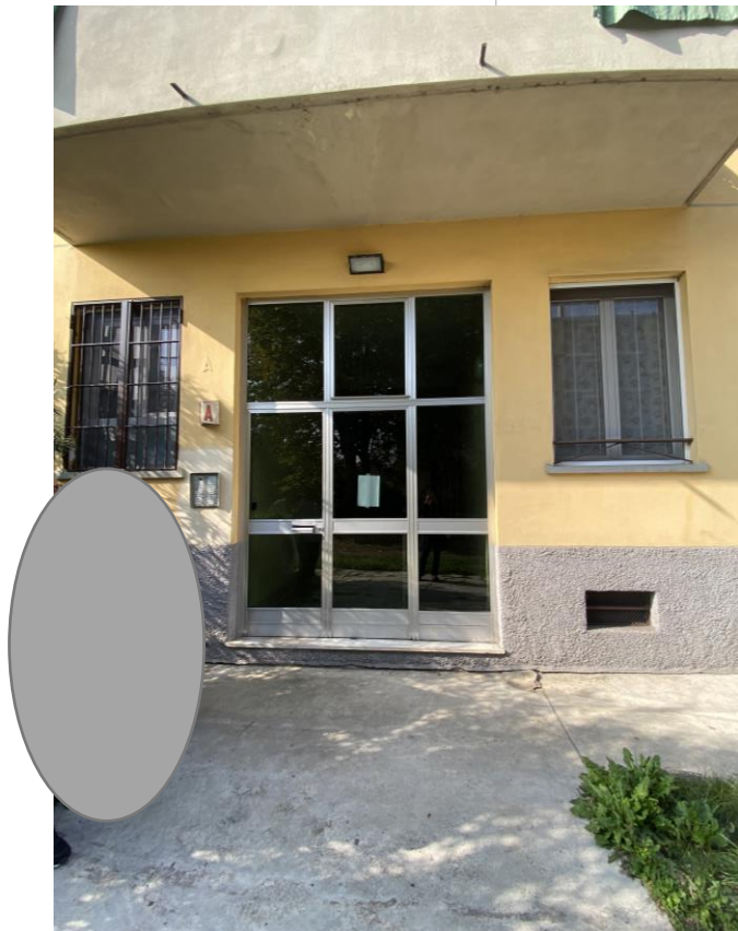
VISTA ACCESSO FABBRICATO
