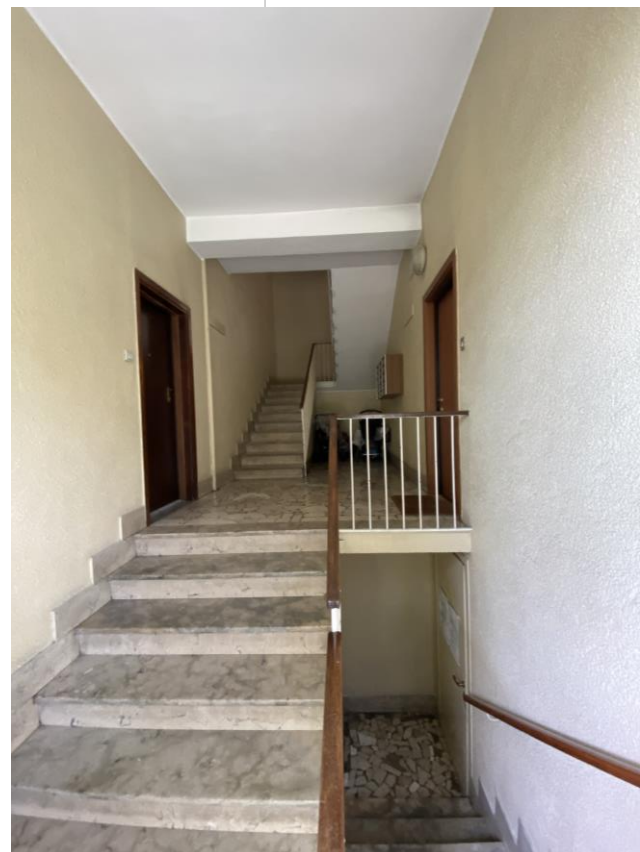
VISTA VANO SCALA COMUNE
