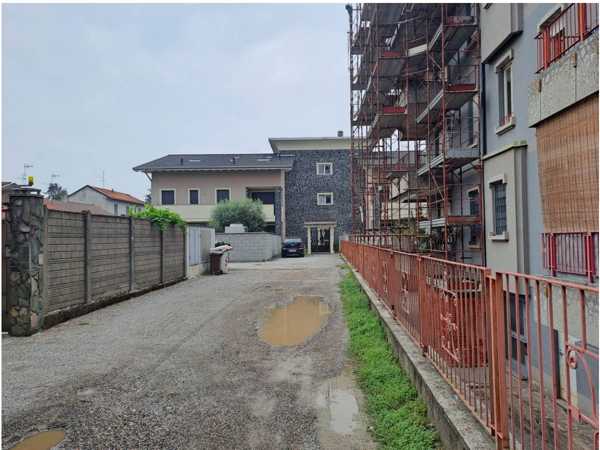
Foto 1 – Vista della strada di accesso. Sullo sfondo la palazzina del civico 21.
