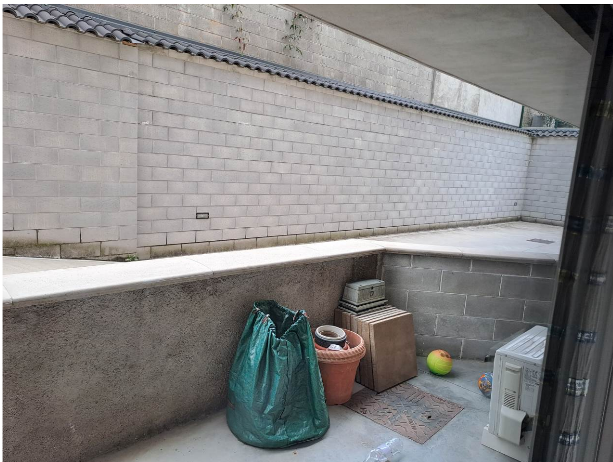
Foto 16 – Il cortile privato al piano seminterrato.
