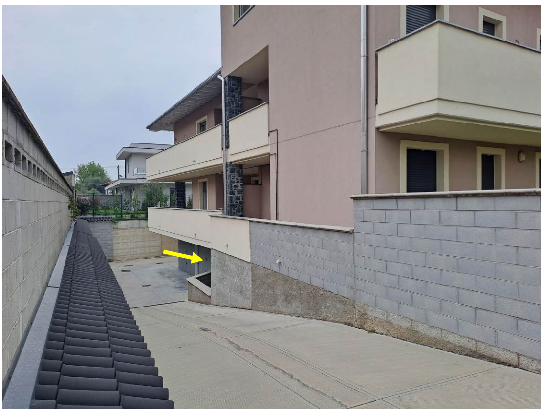
Foto 19 – Vista d'insieme della rampa dei box. Indicato dalla freccia quello in esame.
