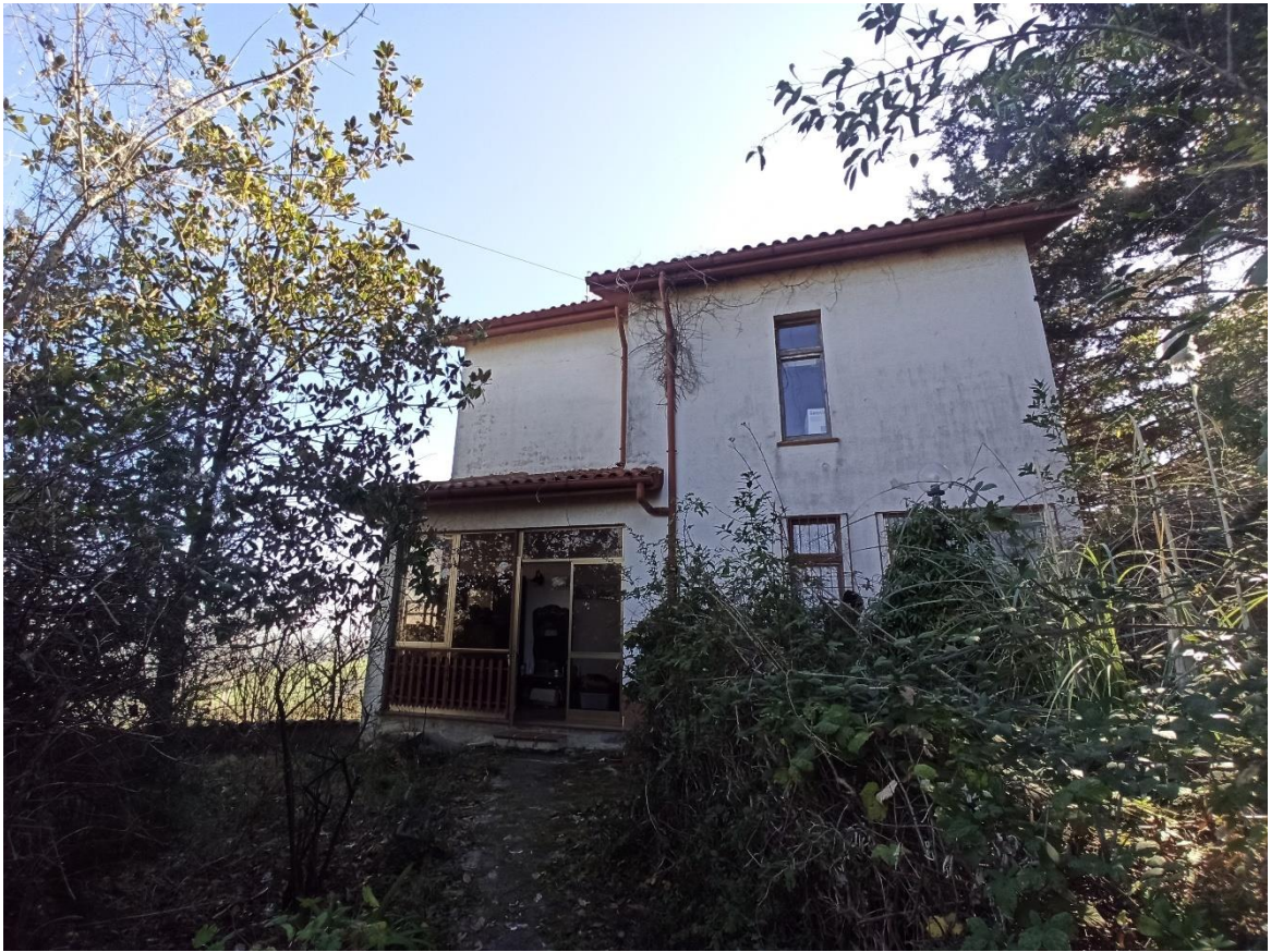
foto 1 – veduta generale del fabbricato da Nord Ovest
