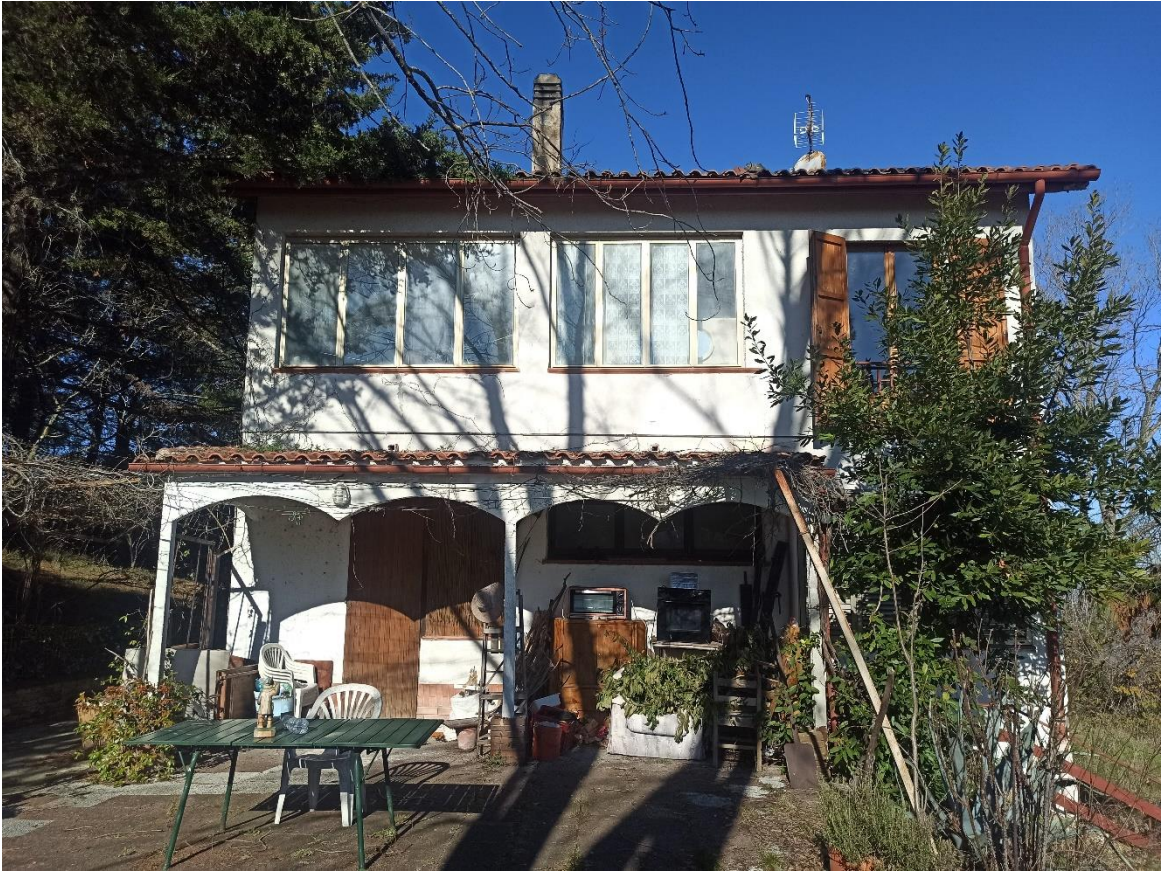
foto 3 – veduta generale del fabbricato da Sud Est
