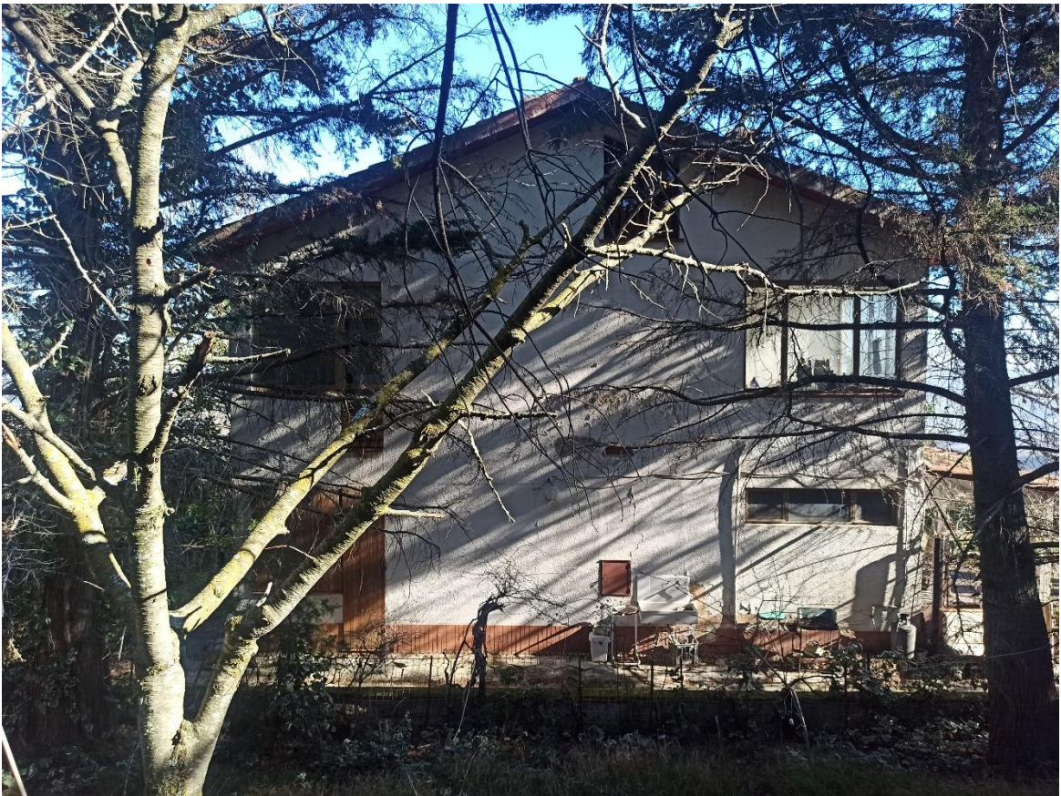
foto 4 – veduta generale del fabbricato da Sud Ovest
