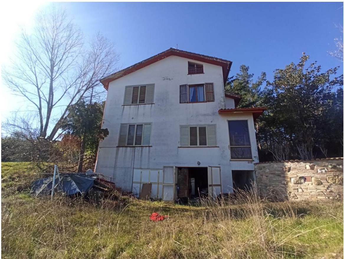
foto 2 – veduta generale del fabbricato da Nord Est
